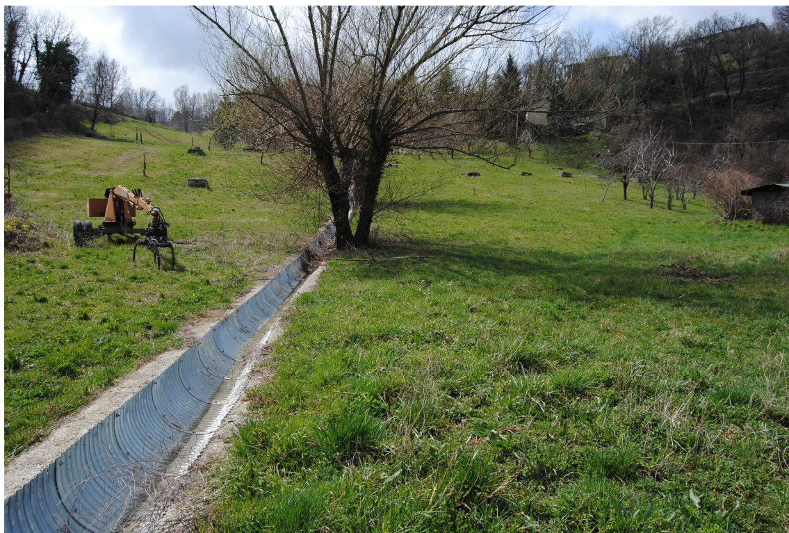
Vista del canal in superficie recentemente rivestito con acciaio corrugato
