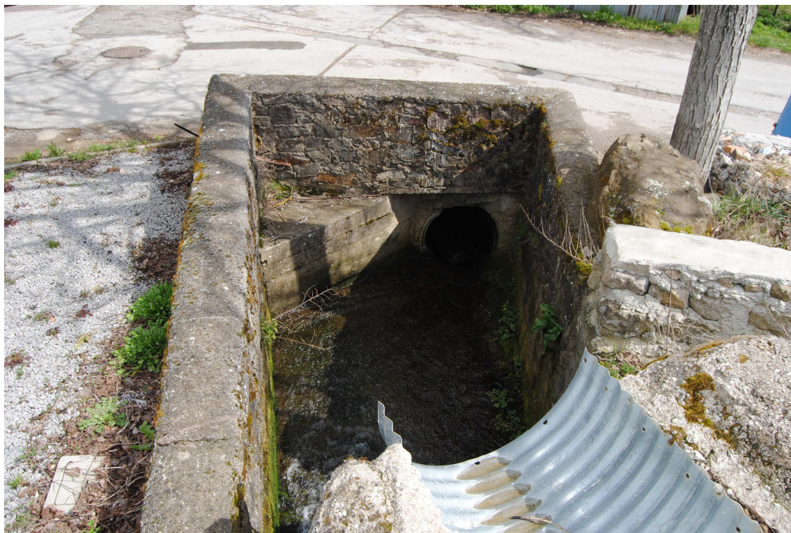
Vista del tubo che costituisce l'inizio del tombamento
