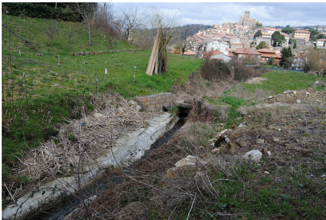
Vista dell'ingresso nella tubazione interrata che raccoglie anche i drenaggi lungo il versante
