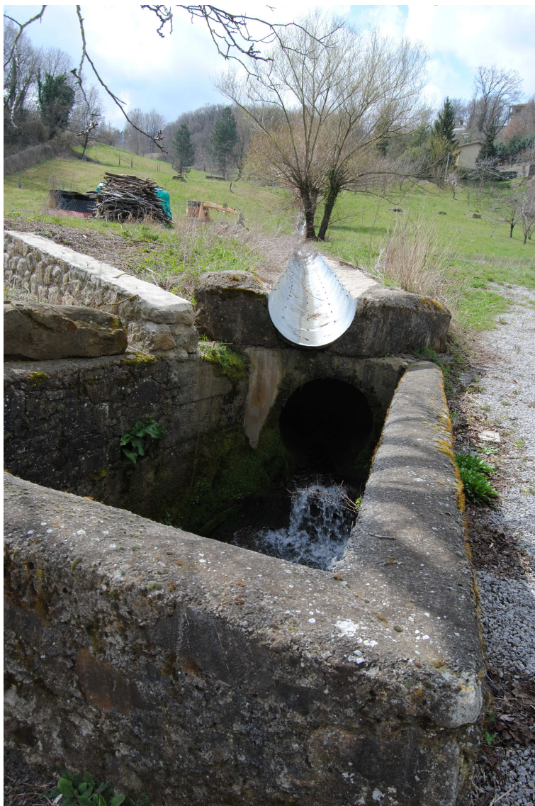
Vista dell'attuale vasca dell'inizio del tombamento con lo scarico del tubo di raccolta del drenaggio e della canaletta soprastante
