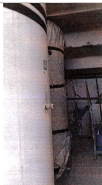
Sottotribuna – Serbatoi acqua calda sanitaria
