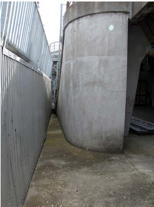
Scala in CLS di Accesso Gradinata
