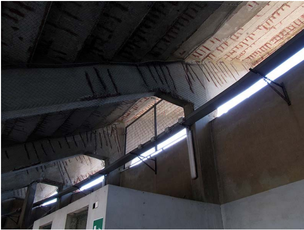
Impianti e Grate in Acciaio
