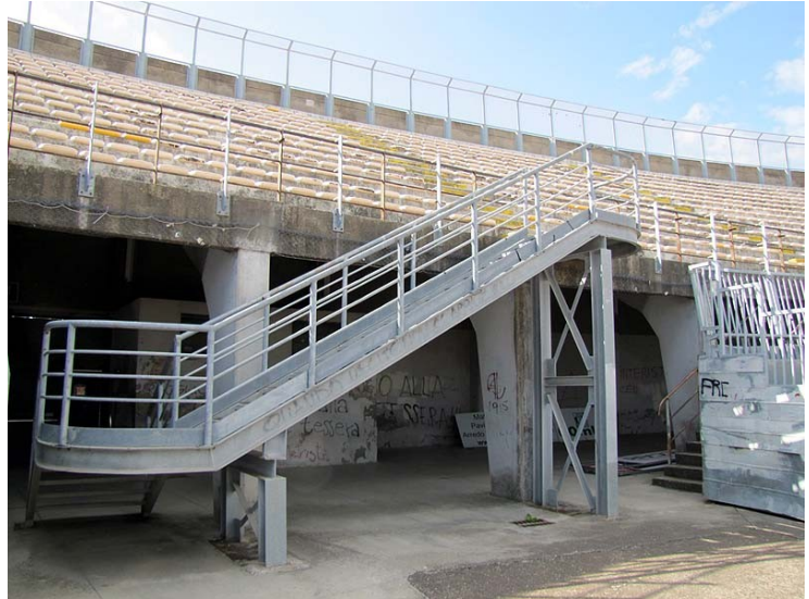
Scala in Acciaio di Accesso Gradinata
