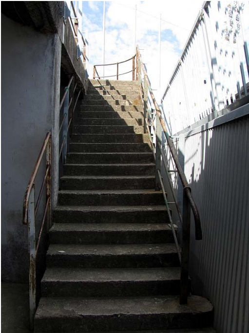
Scala in CLS di Accesso Gradinata
