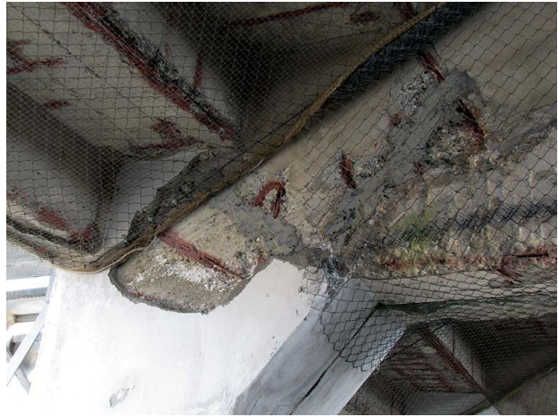
Particolare Nodo Telaio
