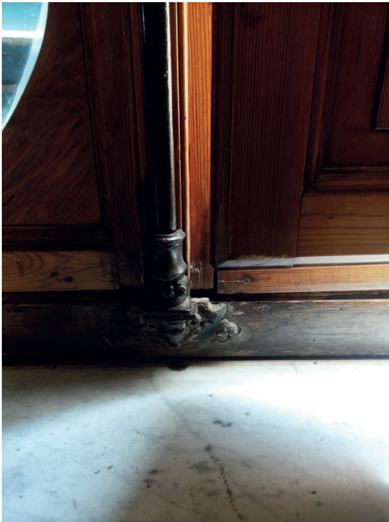
Foto 4) – Particolare della chiusura della maniglia alla Cremonese (in ferro su manufatto in legno intagliato): da recuperare
