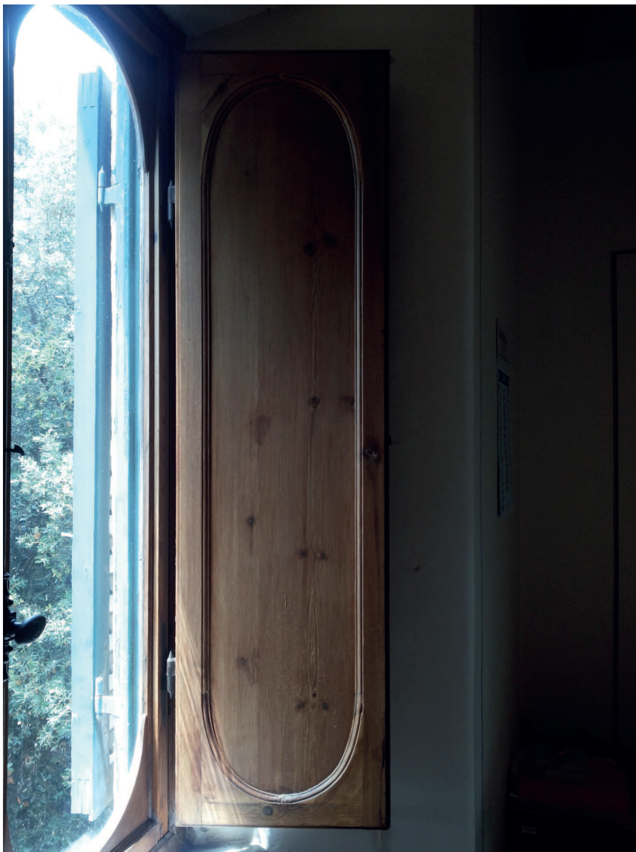
Foto 5) – Particolare dello scuro: da recuperare e ferratura (incassata nella parte interna dell'imbotte) della Persiana
