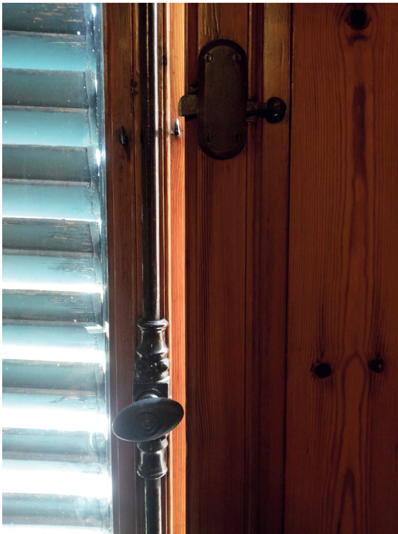
Foto 3) – Particolare della maniglia alla Cremonese: da recuperare unitamente al fermascuro
