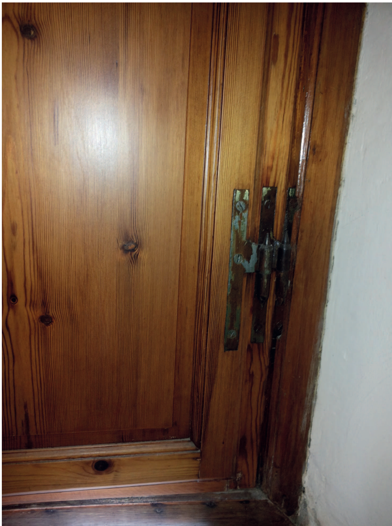
Foto 2) – Particolare della finestra: ferratura di accoppiamento finestra/scuro (da recuperare sia la ferratura che gli scuri)
