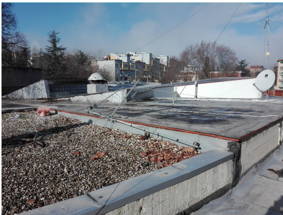
Foto 1: porzione di nuova copertura realizzata contestualmente all'ampliamento e porzione di copertura esistente
