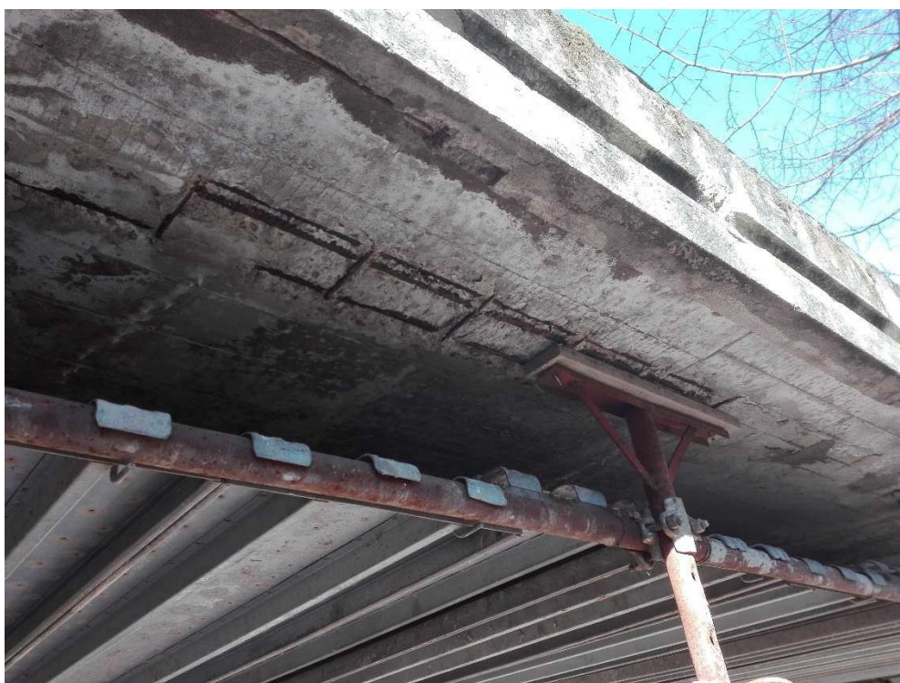
Foto 3: particolare del sotto-copertura – esposizione dei ferri di armatura
