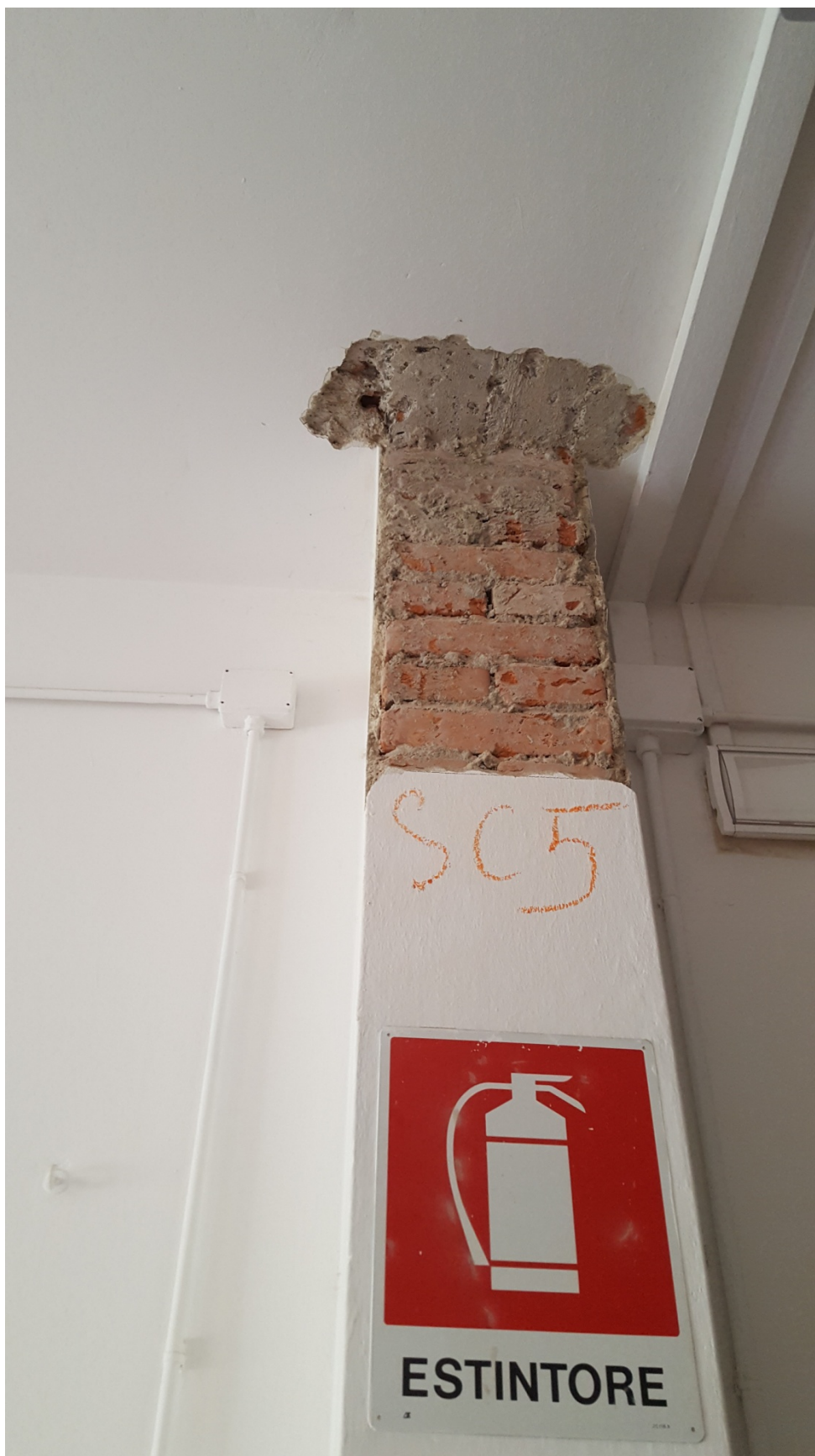
Saggio SC5 sul pilastro in muratura
