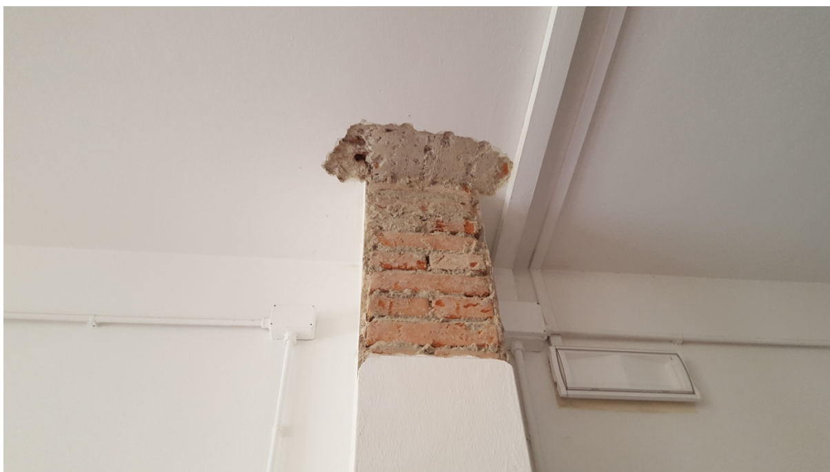
Foto del saggio effettuato sul pilastro in muratura
