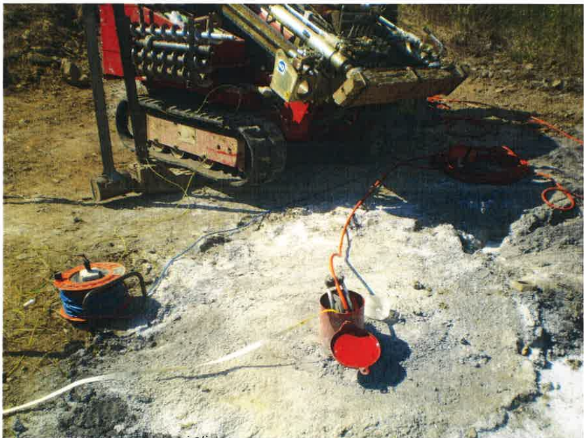
Figura 2 ALLESTIMENTO STRUMENTAZIONE PER INDAGINE DOWN HOLE
