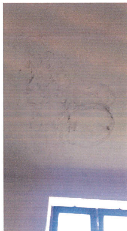
Infiltrazione dal solaio sovrastante
