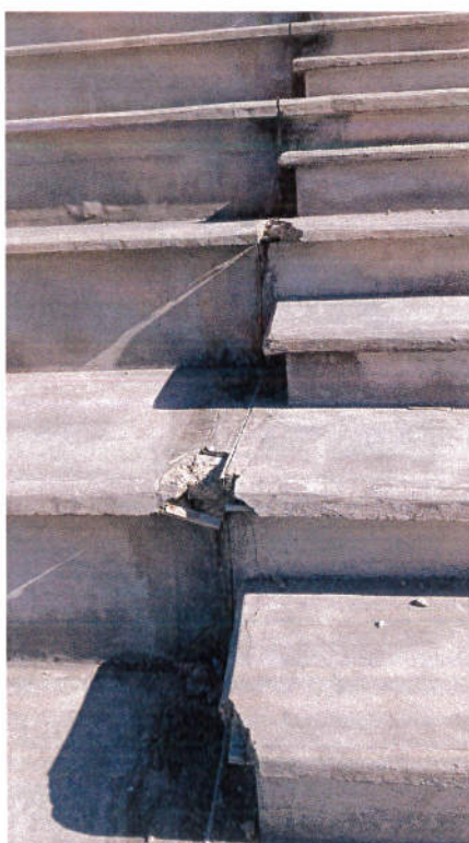
Particolare: gradone rotto
