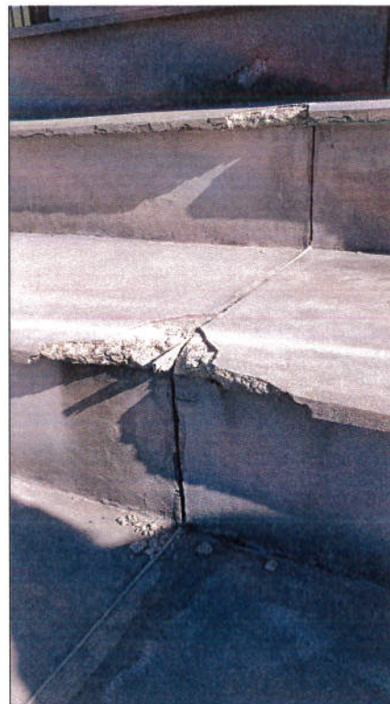
Particolare: gradone rotto
