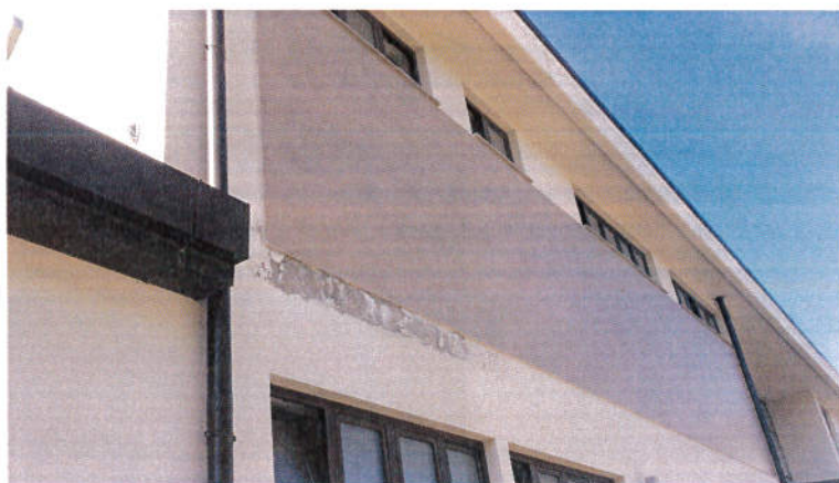
Problemi infiltrazioni solaio docce
