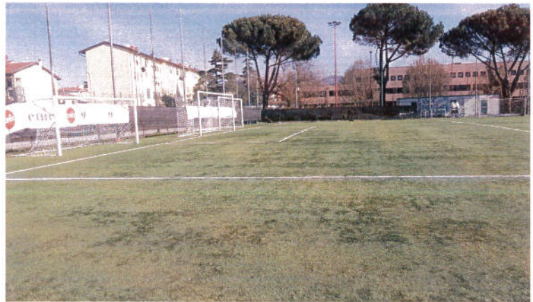
Particolare manto da "ricaricare" e "pettinare"
