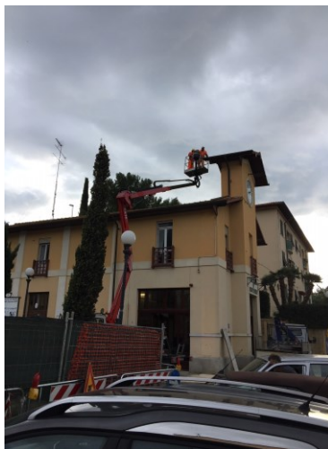
Figura 1: Stazione di Valle
