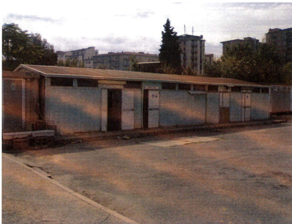
Palazzina servizi prefabbricata
