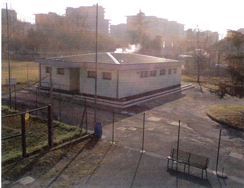
Palazzina servizi in muratura
