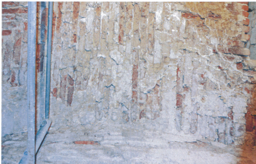
Particolare delle tessiture murarie della volta del secondo piano e suo stato di degrado
