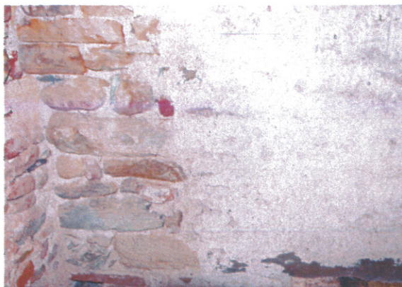
Particolare delle tessiture murarie, dei resti di intonaco
