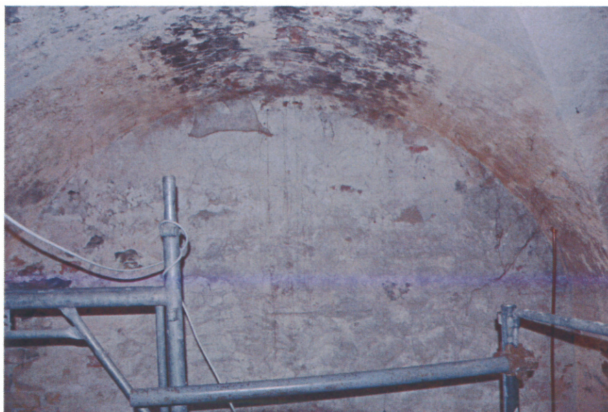
Particolare dello stato di degrado della volta al primo piano
