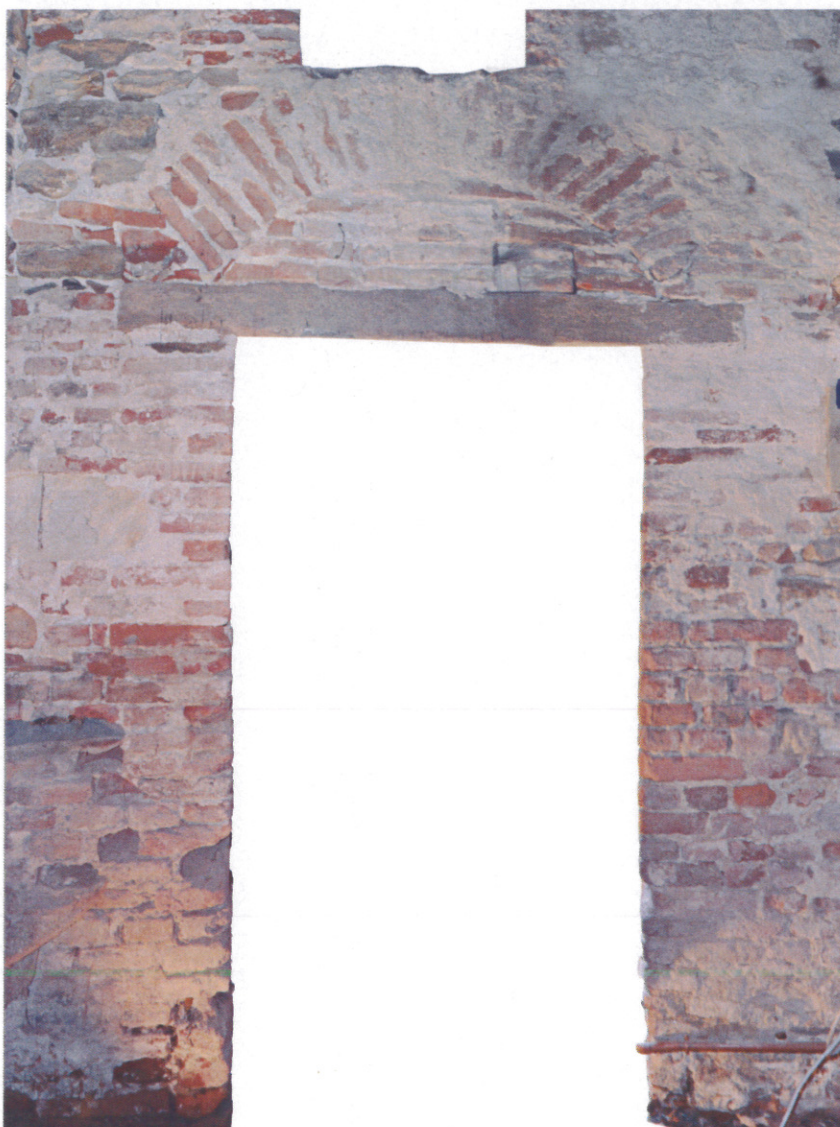
Particolare delle tessiture murarie intorno all'ingresso
