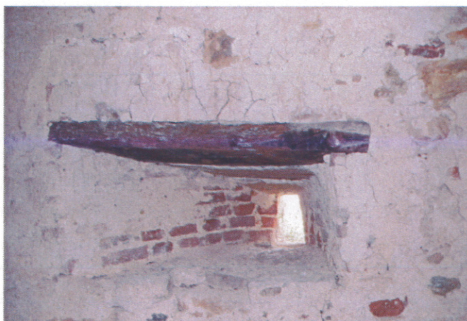
Particolare delle cretture dell'intonaco; fenomeno diffuso sul paramento
