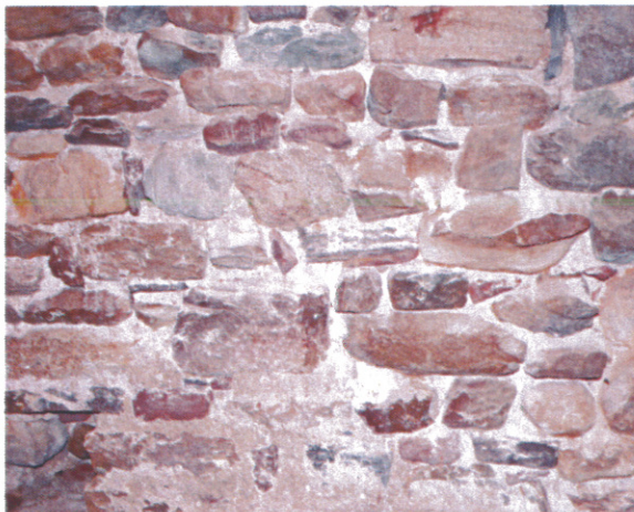
Particolare delle tessiture murarie, dei resti di intonaco e di scialbo
