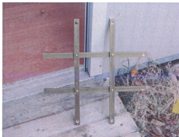
Foto del campione di grata realizzato per le caditoie dello spalto della Torre del Soccorso nel recente restauro
