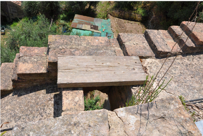
PARTICOLARE DELLE CADITOE E DELLO SCOLO ACQUE LUNGO IL CAMMINAMENTO
