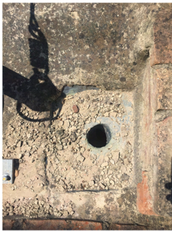
PARTICOLARE DELLE CADITOE E DELLO SCOLO ACQUE LUNGO IL CAMMINAMENTO
