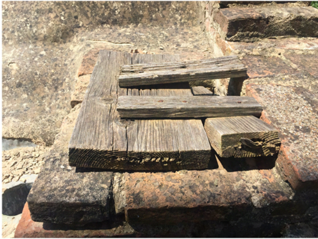
PARTICOLARE DELLE CADITOE E DELLO SCOLO ACQUE LUNGO IL CAMMINAMENTO
