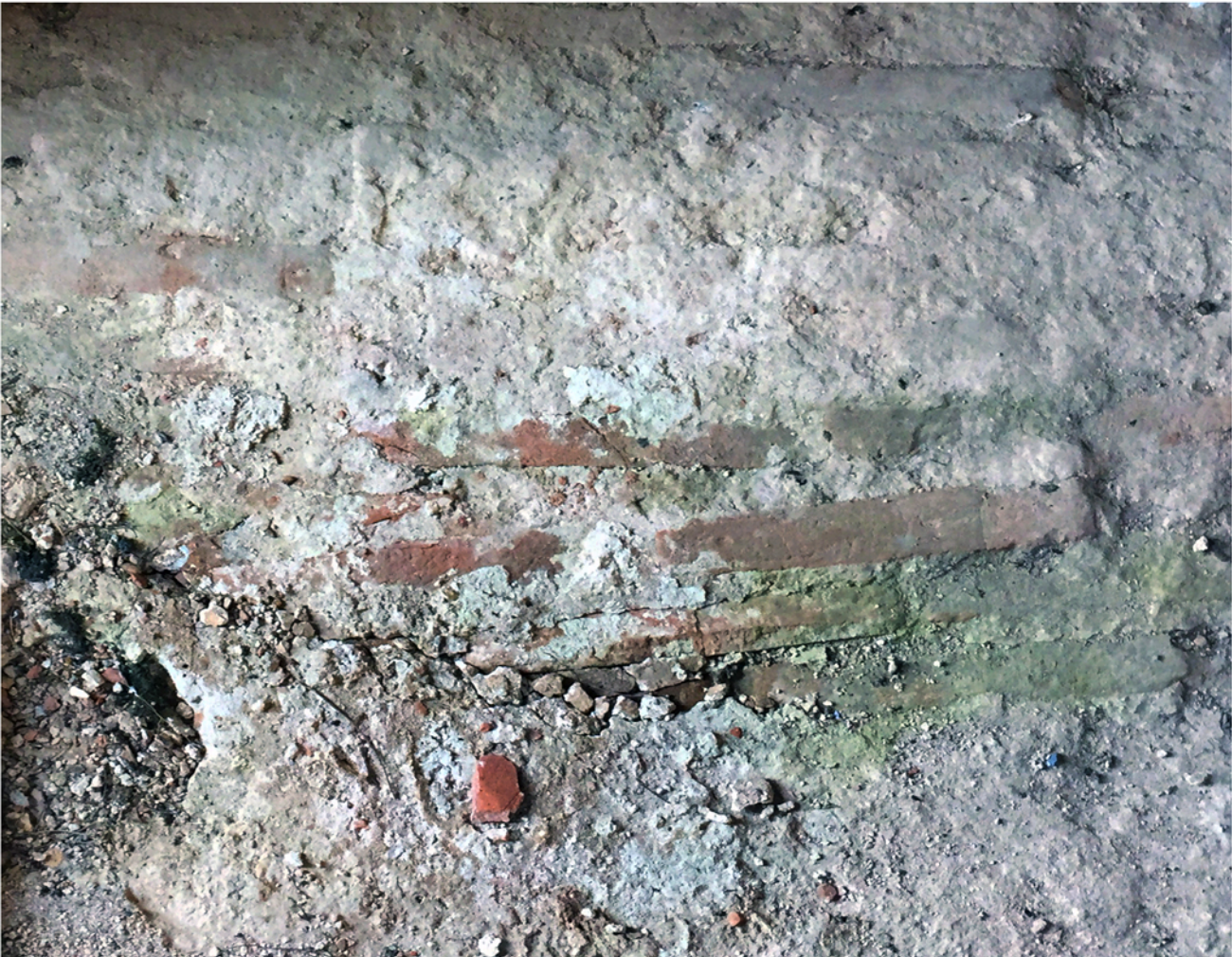
PARTICOLARE SOLAIO LIVELLO 2 (mancanza della pavimentazione)
