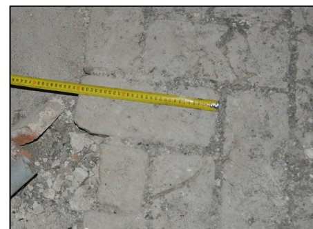
PAVIMENTAZIONE PIANO PRIMO Dettaglio dell'elemento in laterizio esistente con dimensioni 29,7 x 12,5 x 5,7. Pasta del mattone di colore rosso vivo (buona percentuale di ossido di ferro rispetto all'ossido di calcio) e di buona cottura
