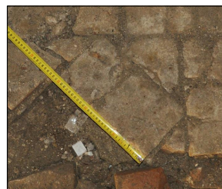
PAVIMENTAZIONE PIANO TERRA Dettaglio dell'elemento in laterizio esistente con dimensioni 30,7 x 17 x 5,7. Pasta del mattone di colore rosso vivo (buona percentuale di ossido di ferro rispetto all'ossido di calcio) e di buona cottura
