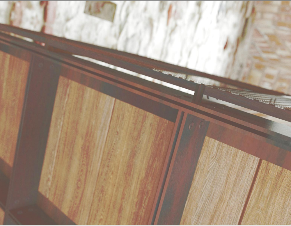
Dettaglio 3 - Innesto dei parapetti sui montanti
