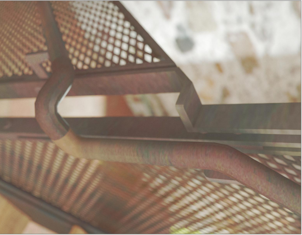
Dettaglio 1 - Snodo corrimano tra rampe ortogonali
