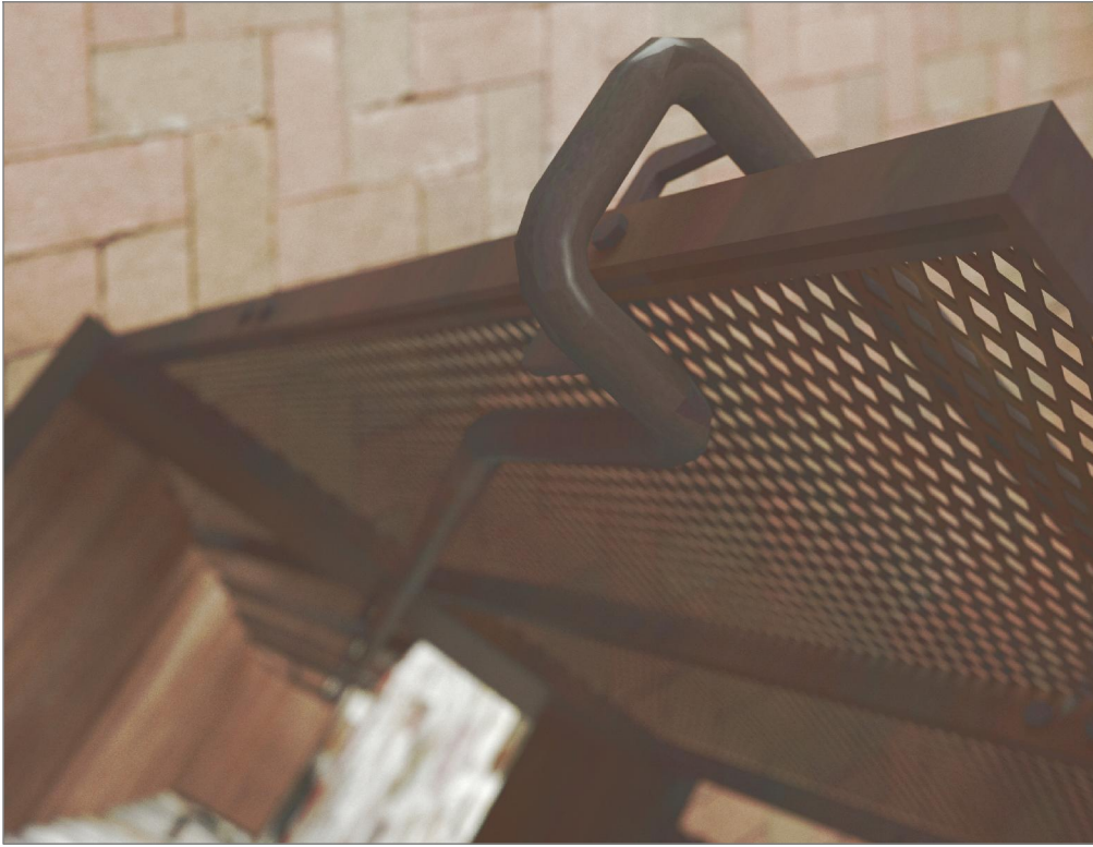
Dettaglio 4 - Snodo corrimano tra rampa e solaio
