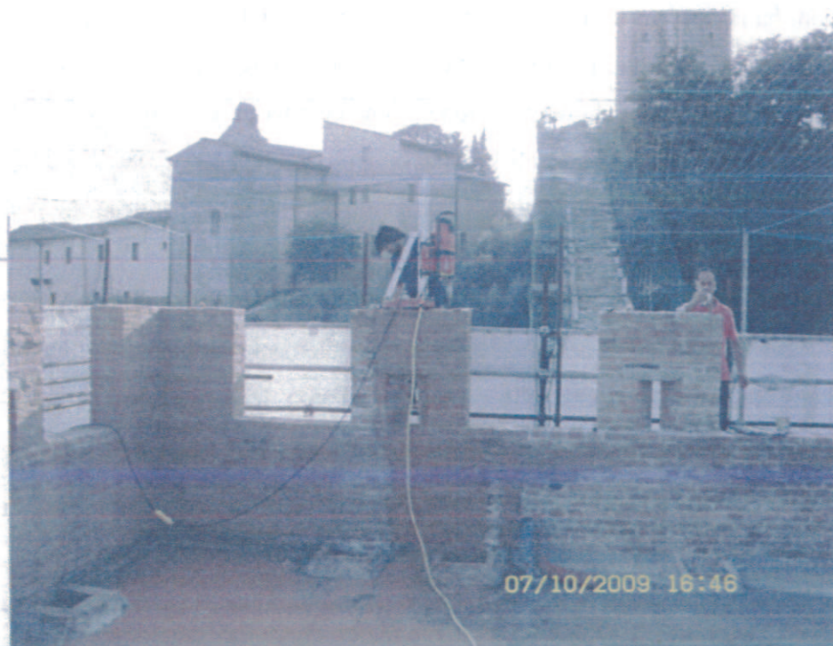
Foto 3 - Perforazioni armate dei merli della Torre di Soccorso
