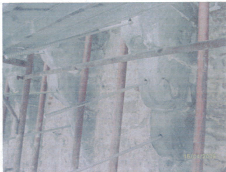
Foto 2 - Perforazioni armate con barre inox nelle mensole dei beccatelli della Torre del Soccorso
