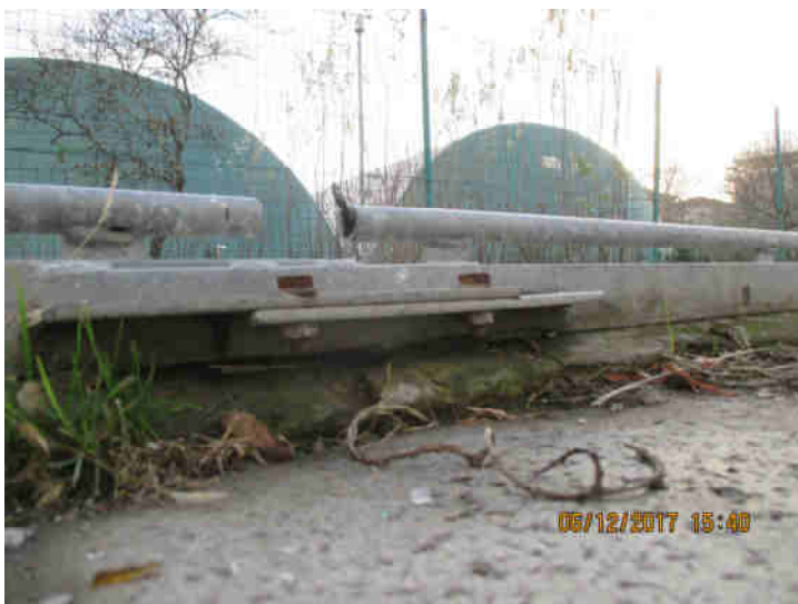
Foto 09, rappresentativa del sistema di raccordo in UPN 100 tra gli ancoraggi a terra. Il sistema è collegato a metà da un "giunto a forcina" a sua volta tirafondato sul cordolo di fondazione.
