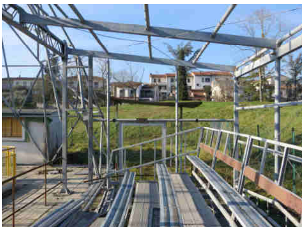
Foto 11, vista interna del blocco tribuna. Si notino i tiranti in bando.
