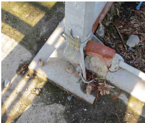
Foto 12, attacco a terra del pilastro d'angolo del blocco tribuna. Si notino i dadi ossidati, la presenza di detriti e la connessione tra piastra di ancoraggio nervata e UPN a terra.
