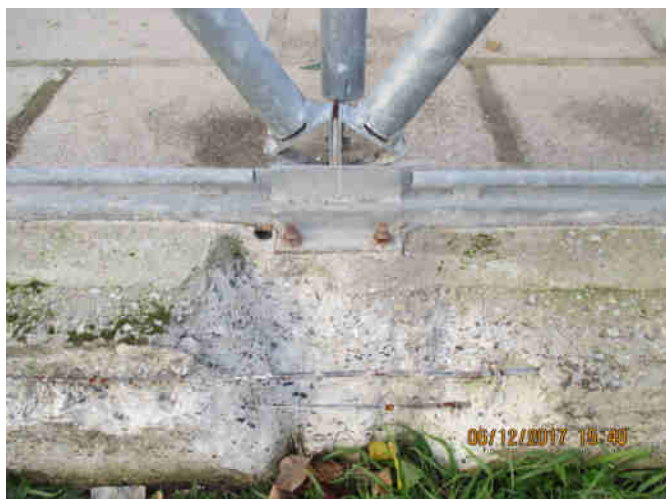
Foto 07, nodo di connessione a terra. Attraverso il saggio eseguito dalla Stazione Appaltante si notano le barre lisce filanti che compongono due dei 4 ferri di armatura longitudinale del cordolo.
