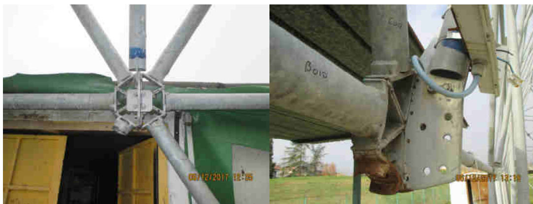
Foto 14, 15, asportazioni (14) e mancanze (15) di aste di collegamento tra alcuni nodi del primo livello e del livello terra. I calcoli strutturali dello stato attuale delle strutture hanno tenuto conto di tali mancanze.
