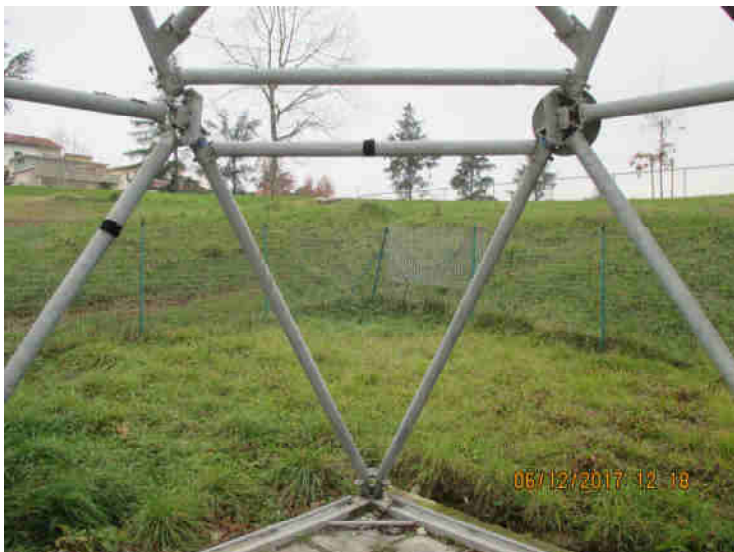
Foto 08, rappresentativa del sistema di raccordo d'angolo della struttura
