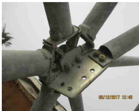
Attacco asta verticale interna al nodo tipo
