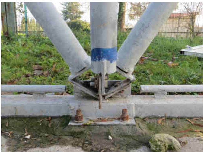
Foto 05, nodo di connessione a terra. Si notano anche i profili UPN rovesciati che collegano a terra i nodi tra loro.
