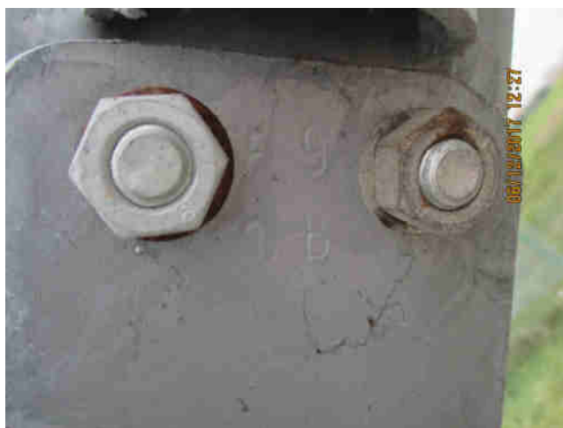
Foto 06, dadi di chiusura delle piastre in un nodo intermedio
