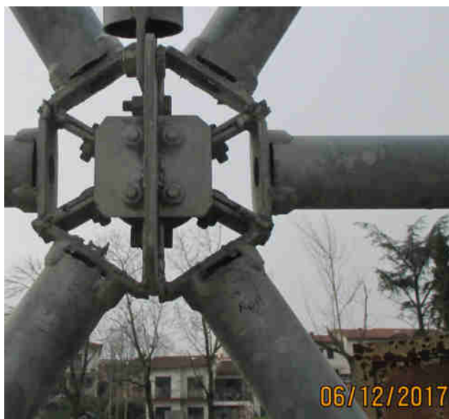
Foto 03, nodo tipo di connessione delle aste. Si notino le saldature per altro di scarsa qualità, eseguite tra le piastre imbullonate dei triangoli spaziali
