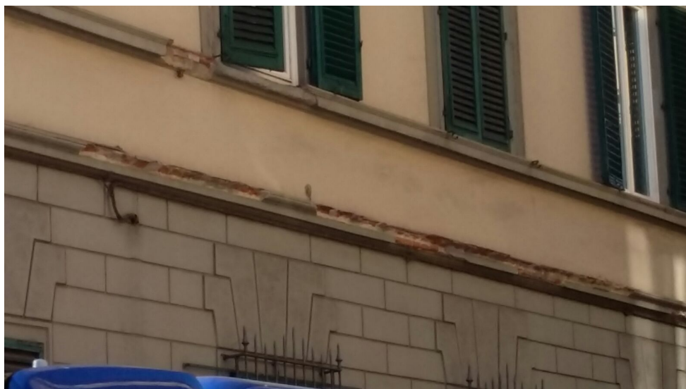
Viste particolareggiate degli elementi di decoro ammalorati:
