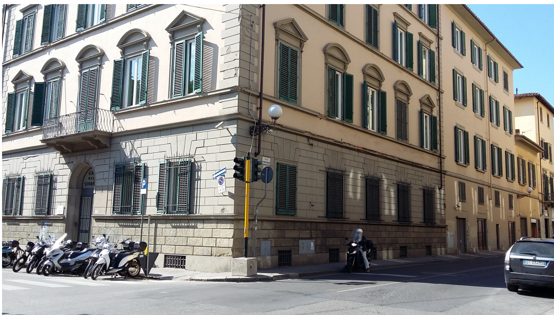
Vista dell'angolo dell'immobile, attualmente è presente impianto semaforico
