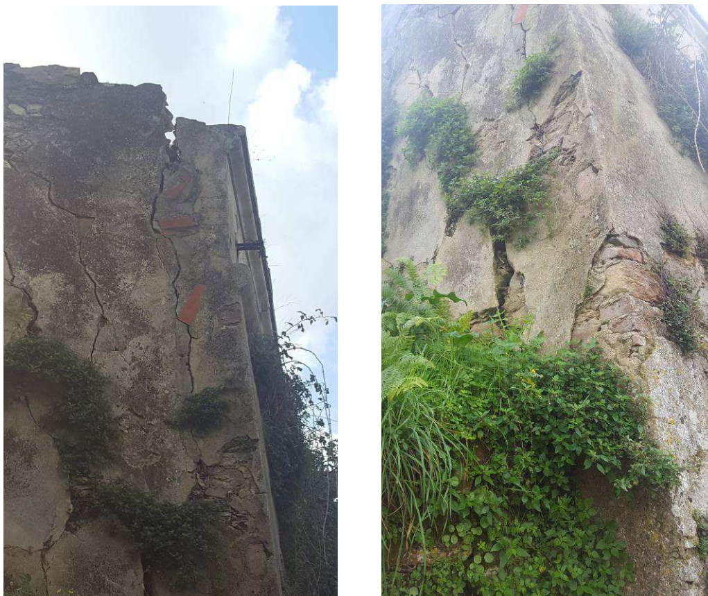
Figura 12 – Lesionamento delle strutture esistenti
