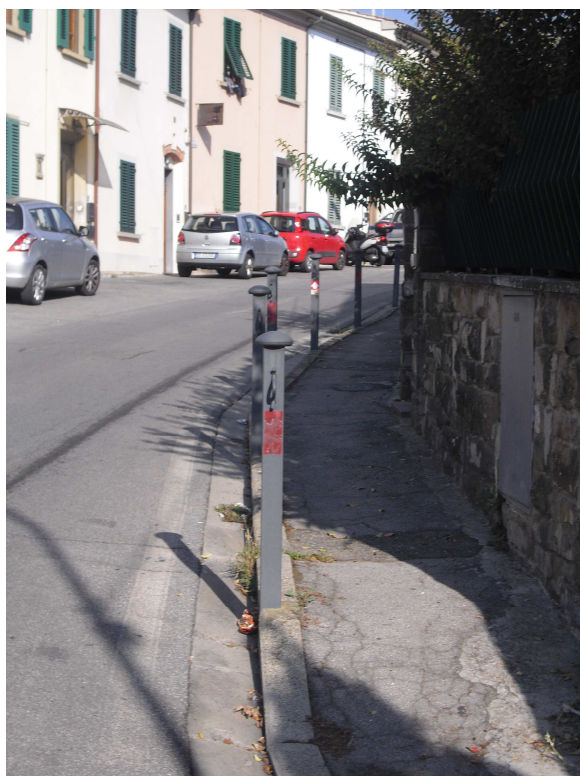
Marciapiede altezza incrocio via Don Domenico Mazzoni oggetto di rifacimento del tappeto di usura, sostituzione zanella e cordonati rotti
