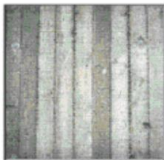
Figura 58.9 - Variazioni di colore sulla superficie in evidenza poche ore dopo la rimozione delle casseforme
