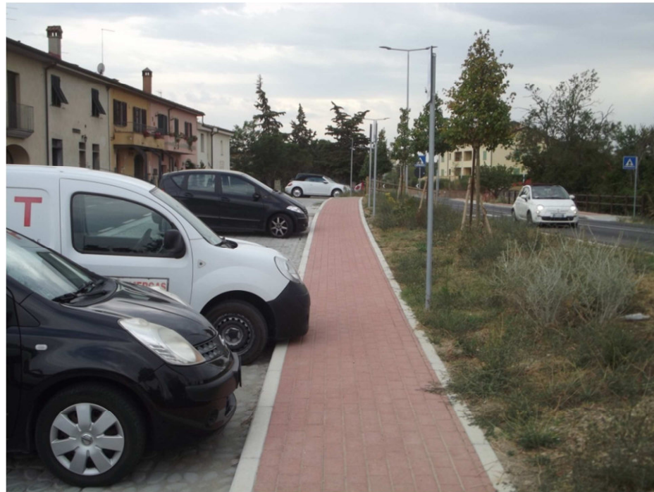
Figura 2- esempio di camminamento in mattonelle di cemento tra due cordonati.
