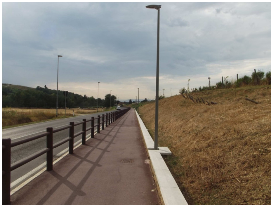
Figura 3- esempio di camminamento in asfalto colorato tra cordonato e muretto al piede del ciglio
