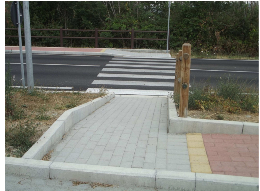
Figura 4- cambiamento di pendenza del percorso segnalato anche con mattonelle tattili
