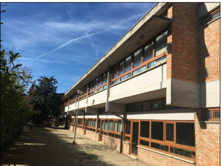
FOTO 4 - Vista Pensiline n. 7
