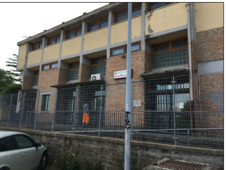
FOTO 6 - Vista Pensiline n. 10 - 11 - 12 - 13
