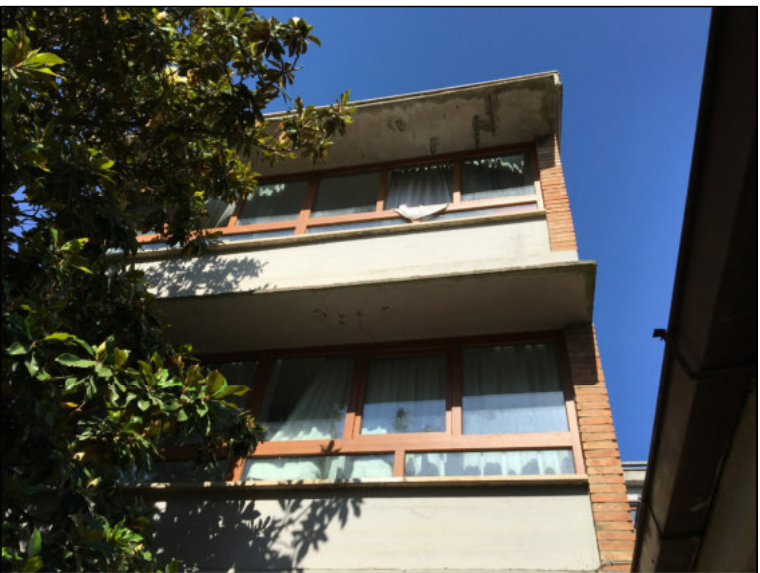
FOTO 2 - Vista Pensiline n. 3 - 4
