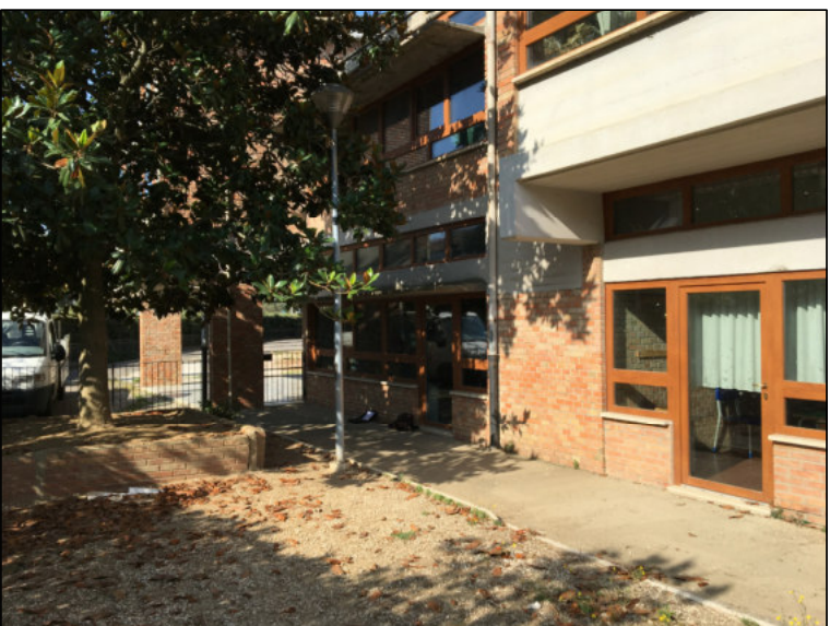
FOTO 3 - Vista Pensiline n. 5 - 6
