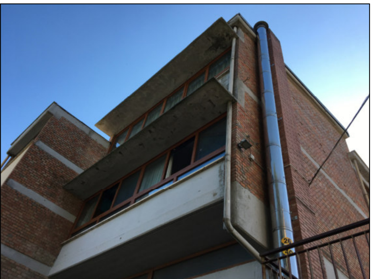
FOTO 5 - Vista Pensiline n. 8 - 9
