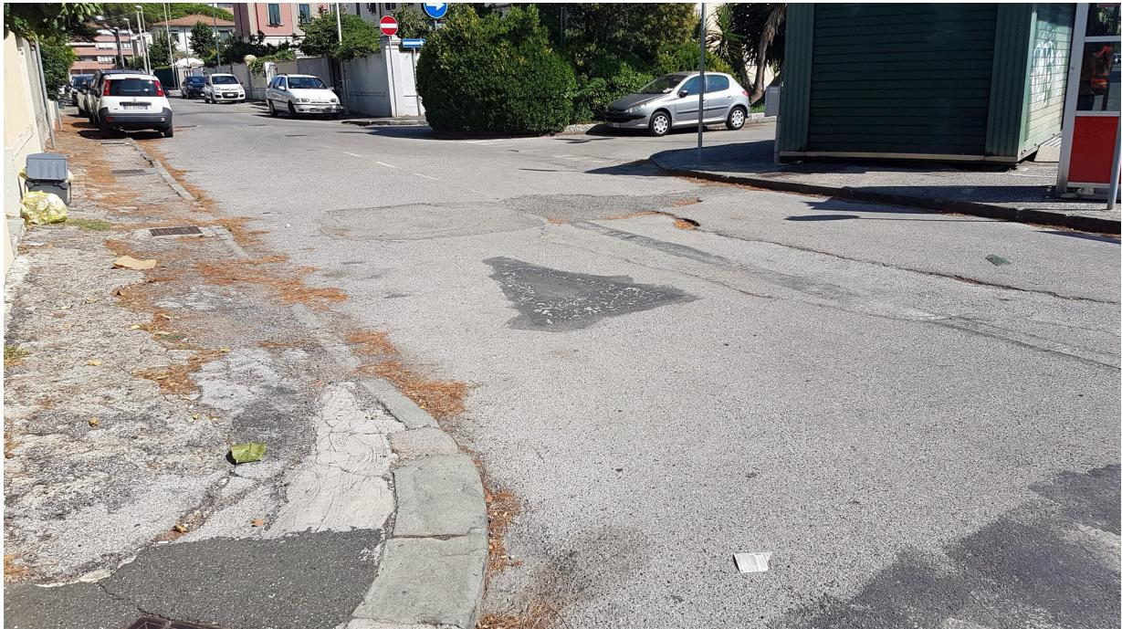
E' previsto per entrambe le tipologie di interventi il ripristino in quota dei chiusini posti a copertura dei pozzetti d'ispezione dei sottoservizi e l'eventuale sostituzione dei chiusini deteriorati e fuori norma con nuovi in ghisa sferoidale della classe adeguata.
