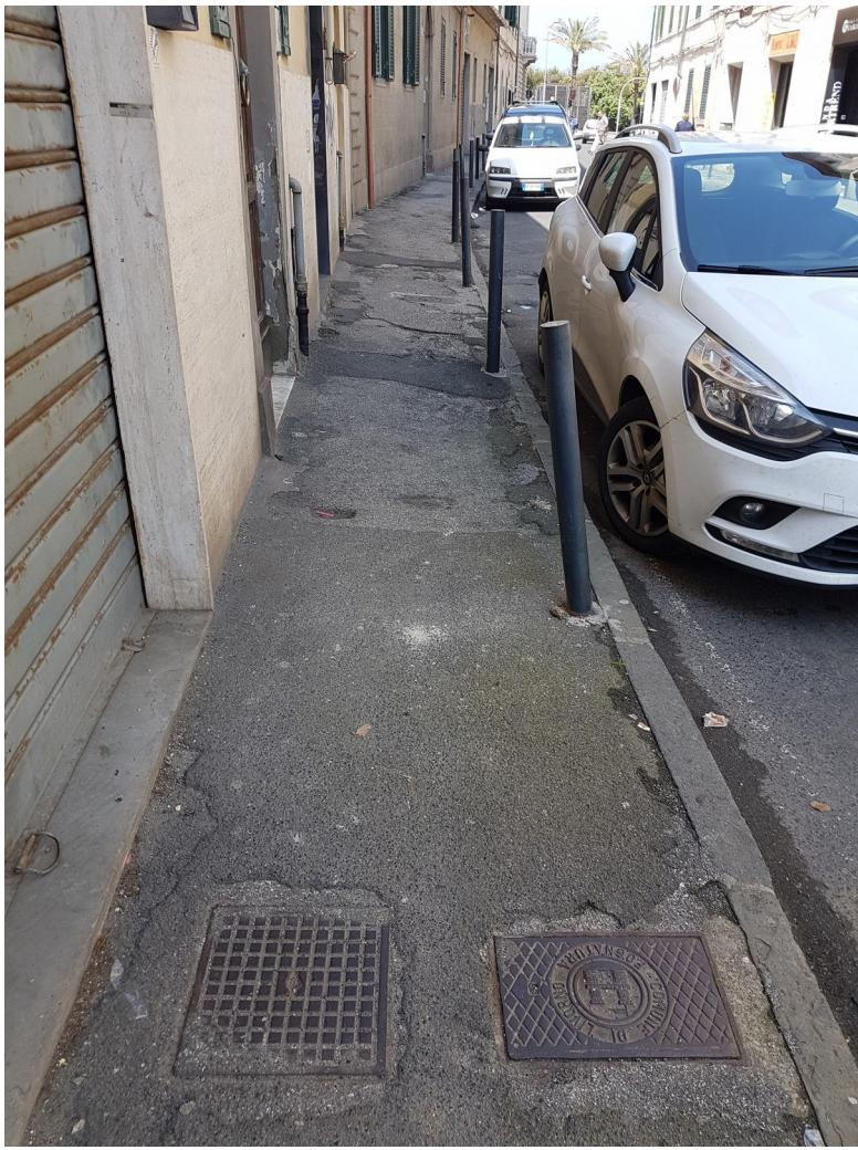
Attualmente i manufatti hanno una larghezza variabile da ml. 0,9 a ml. 2,00, per una superficie di circa mq.320, e sono utilizzati soltanto per il passaggio dei pedoni, poiché dal 2005 sono stati installati con "ordinanze n.19 e n.97" un totale di 51 dissuasori di sosta, necessari per far desistere i conducenti ostinati dalla sosta selvaggia, causa del deterioramento dei marciapiedi.
