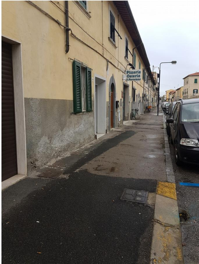
Considerato che sul tratto di marciapiede non si evidenziano particolari cedimenti strutturali, le opere di straordinaria manutenzione prevederanno soltanto una scarifica superficiale del marciapiede ammalorato per uno spessore di cm.3/4, con conseguente posa in opera di tappeto in conglomerato bituminoso 0/5 mm. per marciapiedi. E' previsto il ripristino in quota e l'eventuale sostituzione dei chiusini deteriorati e fuori norma con nuovi in ghisa sferoidale della classe adeguata.
