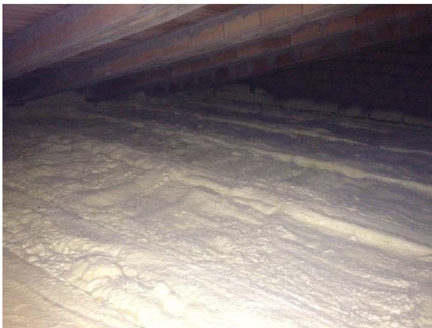
Esempio di sottotetto isolato con schiuma poliuretanica
