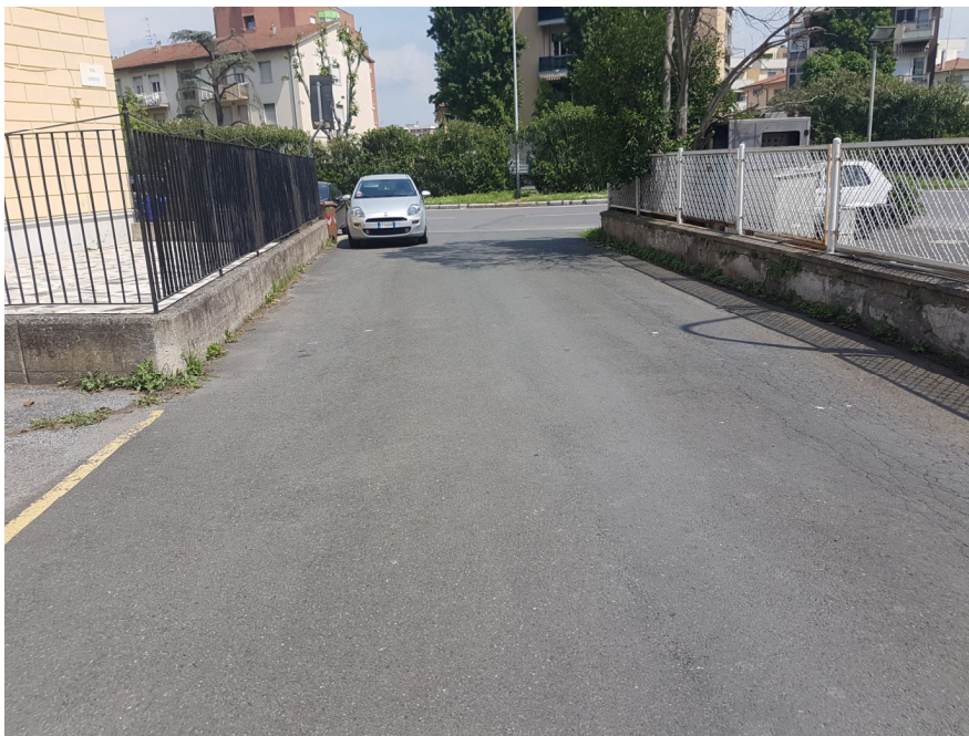
Tratto di Via di Coteto con marciapiede da realizzare
