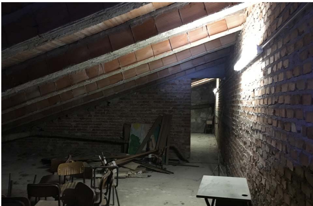
Fig. 2.8– Immagine illustrativa copertura plesso US2
