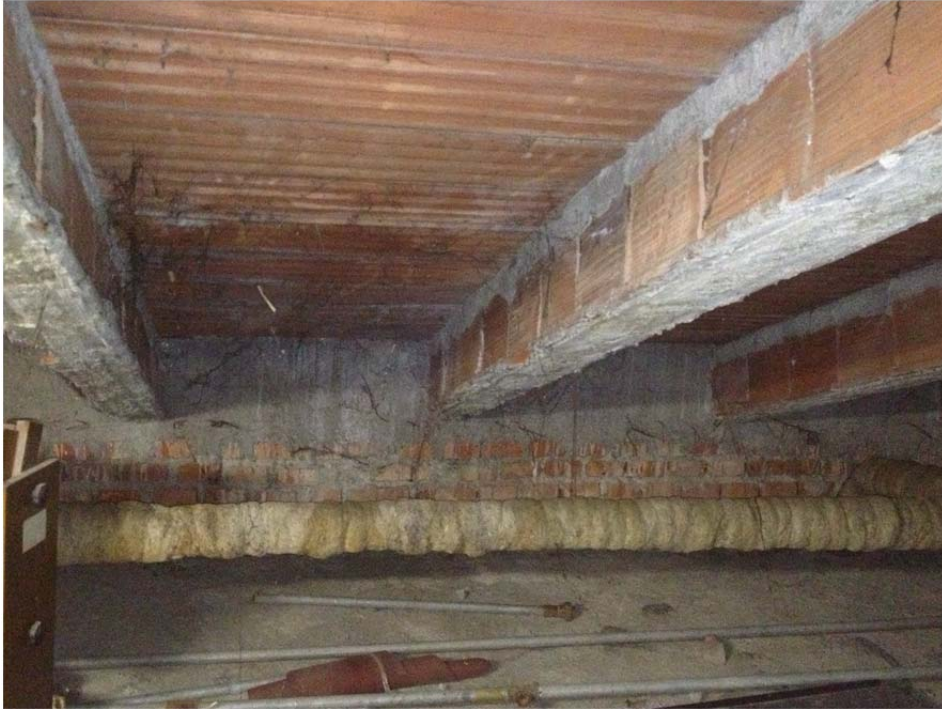
Fig. 2.9– Presenza di cordolo perimetrale in copertura plesso US2
