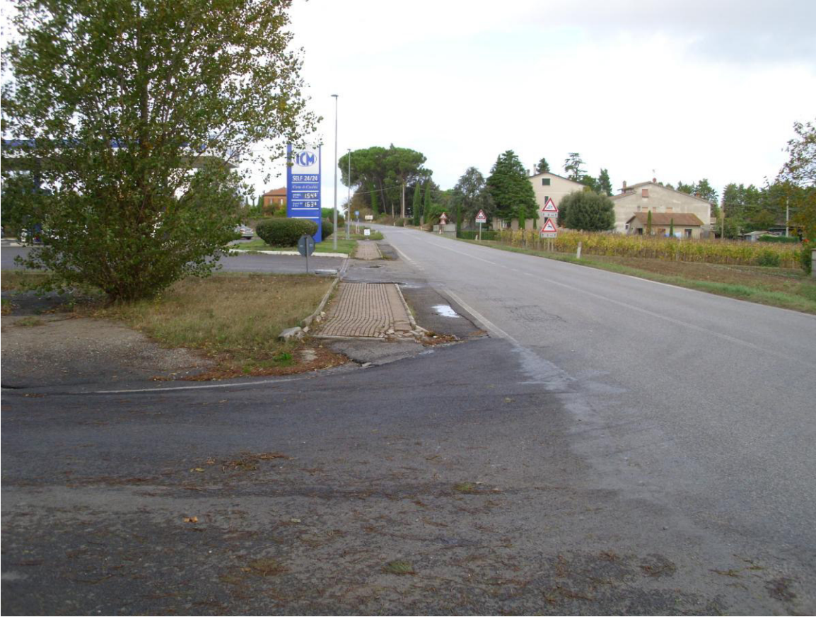
Zona inizio impianto di illuminazione all' innesto con Via delle Tre Berte. Vista verso nord
