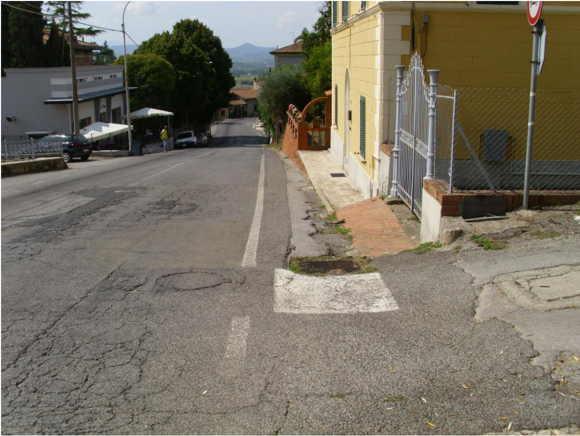
Zona termine marciapiede. Vista in uscita dal centro abitato
