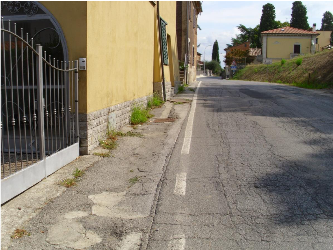
Vista verso est e verso zona termine percorso pedonale
