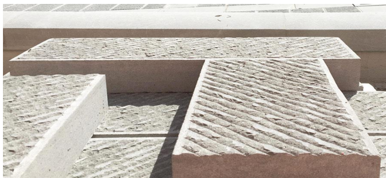
Fig. 2 – Foto Pavimentazione in Pietra Tipo.
