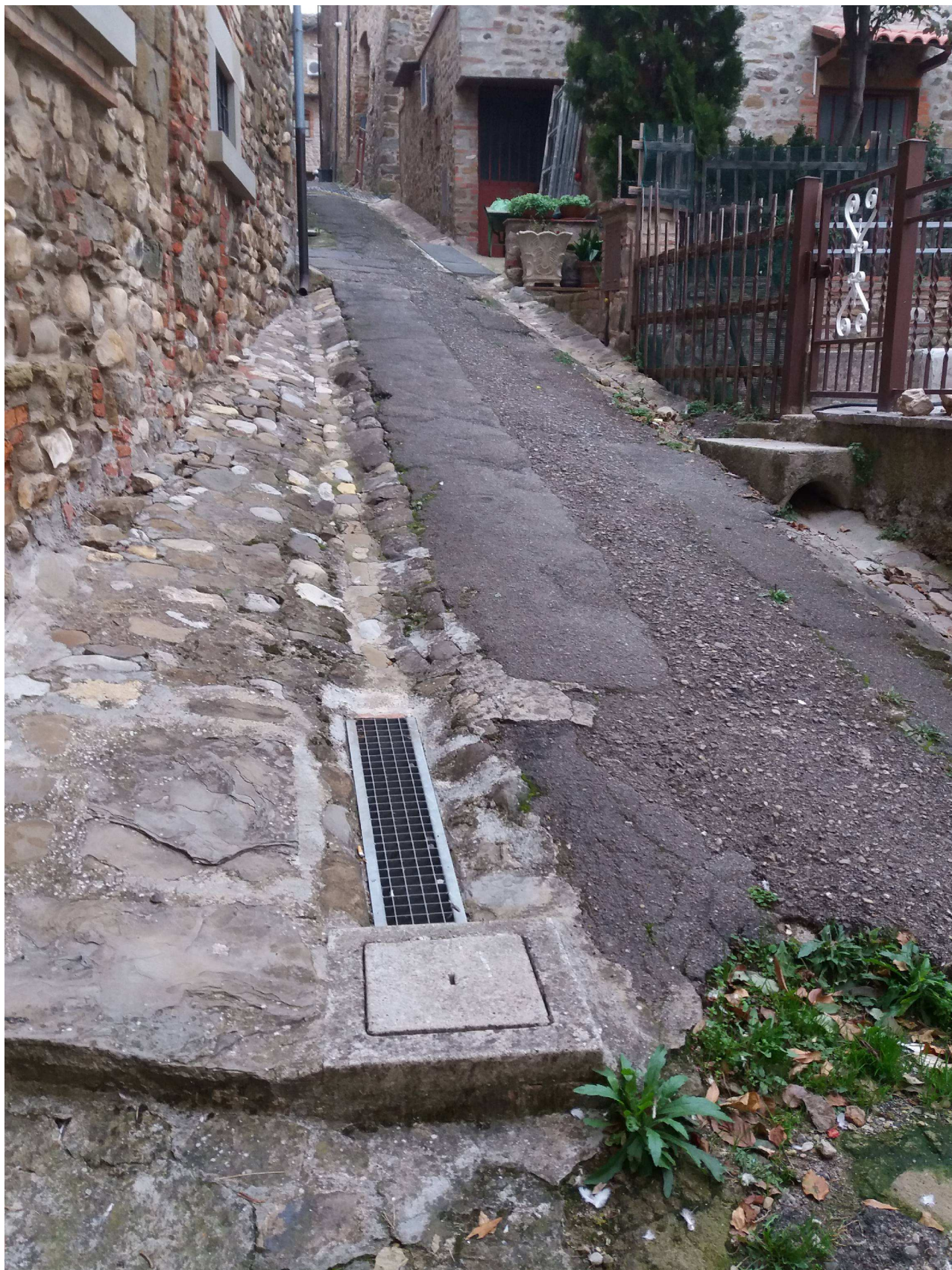
Zona intermedia percorso centrale - particolare zanelle da restaurare e pavimentazione in bitume da sostituire con massetto architettonico e ricorsi in mattoni posti a coltello , con pozzetti e griglie da sostituire
