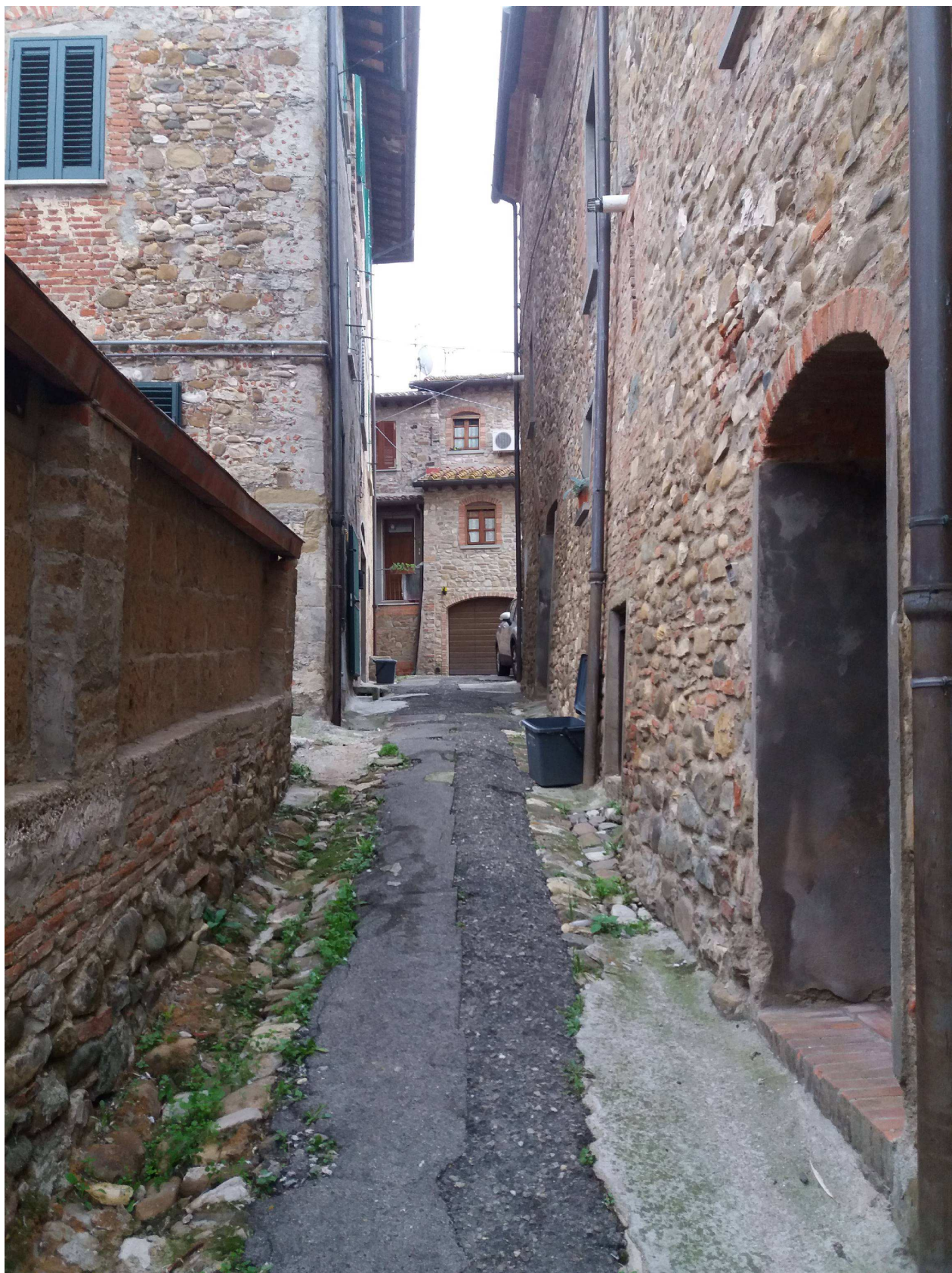
Zona alta percorso centrale - particolare zanelle da restaurare ed in parte da integrare con sostituzione delle porzioni in cemento , pavimentazione in bitume da sostituire con massetto architettonico e ricorsi in mattoni posti a coltello
