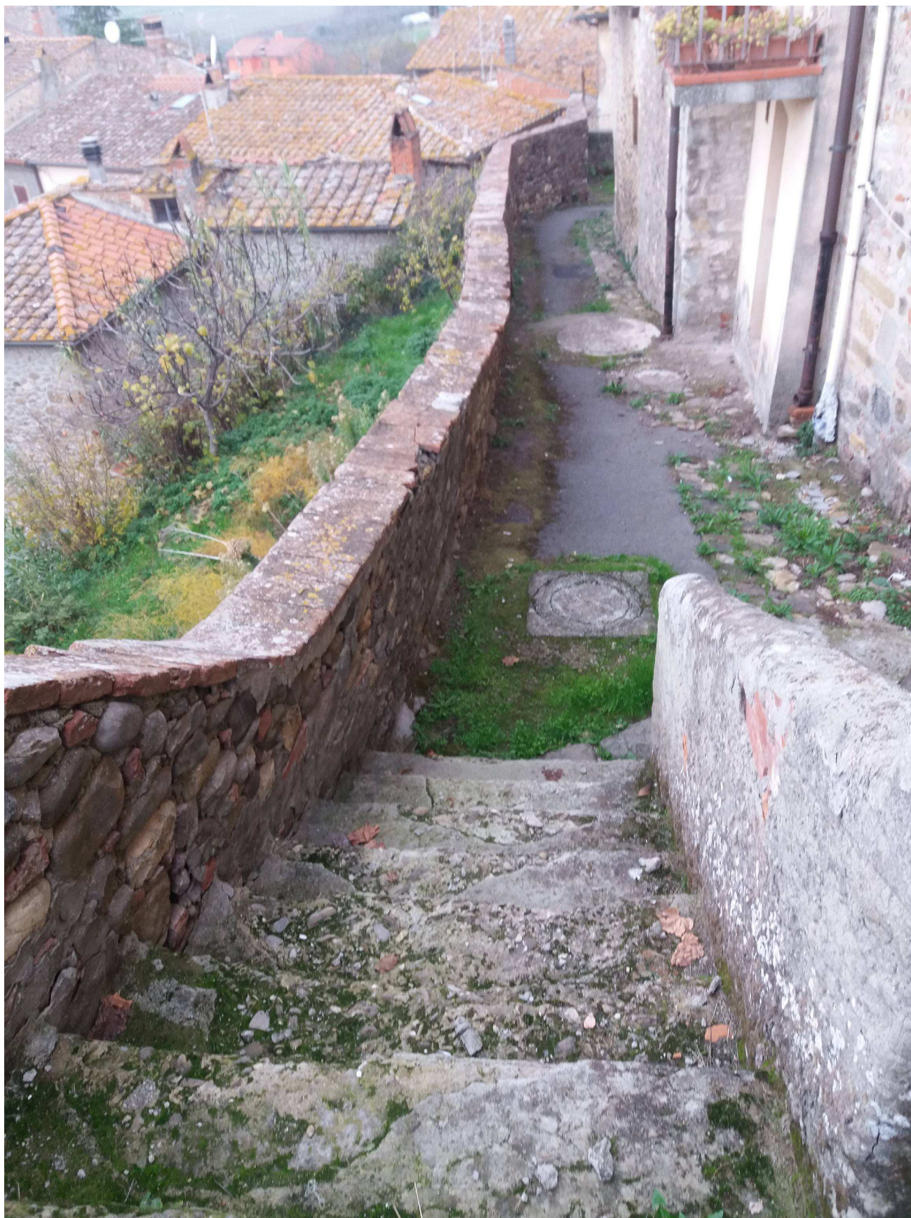
Tratto del parapetto percorso di ronda da intervenire con tecnica “scuci cuci” e delle scale da riqualificare
