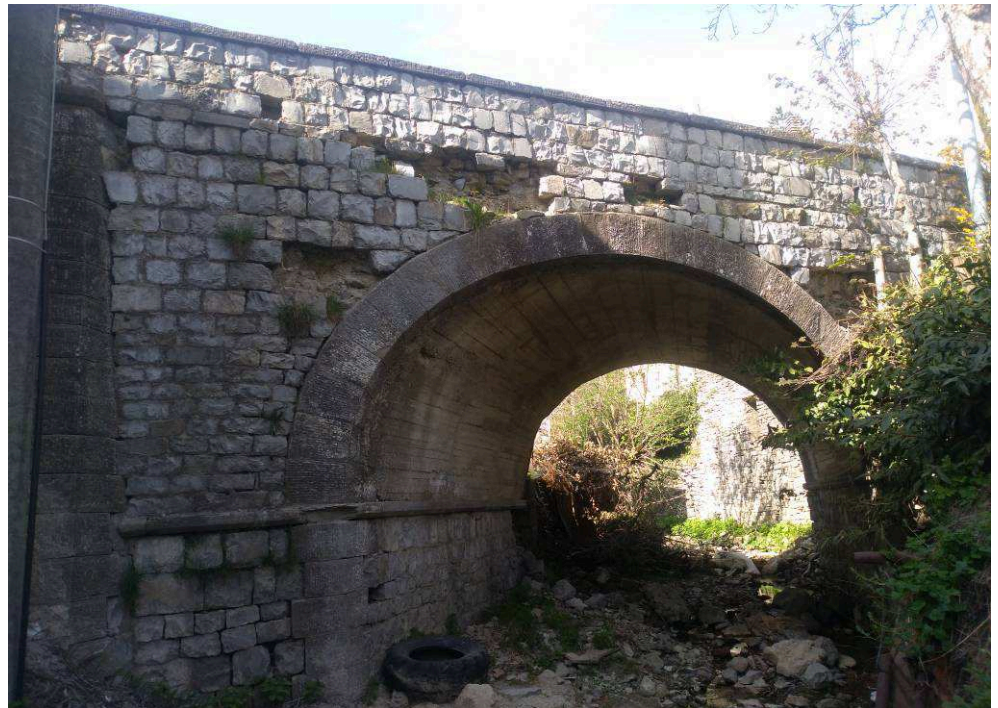
Vista ponte lato Sud (valle)
