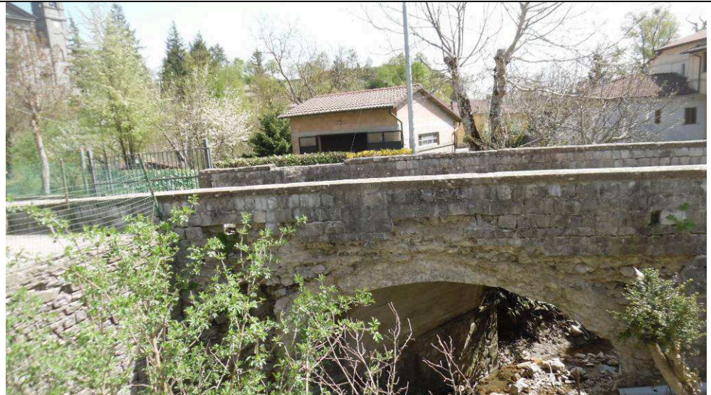
Vista ponte lato nord (monte)
