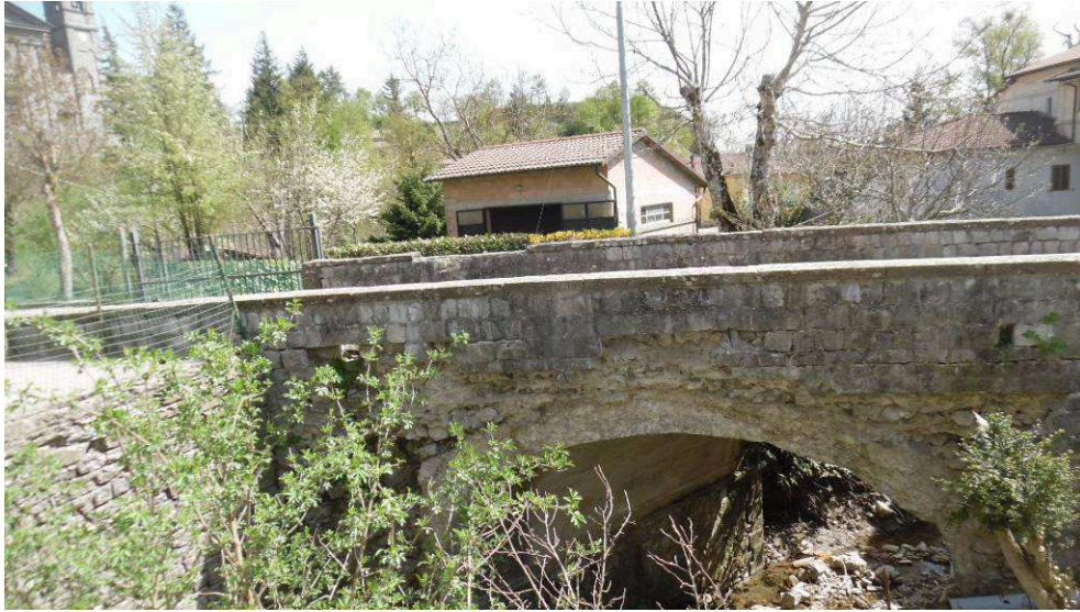
foto 1 – Vista ponte lato Nord (monte)
