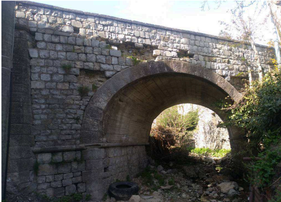
foto 2 – Vista ponte lato Sud (valle)
