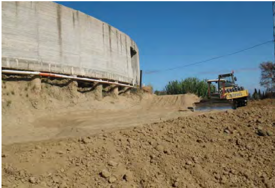
Foto 5 – Lavori di stabilizzazione e ricostruzione del versante (Luglio-Agosto 2011)
