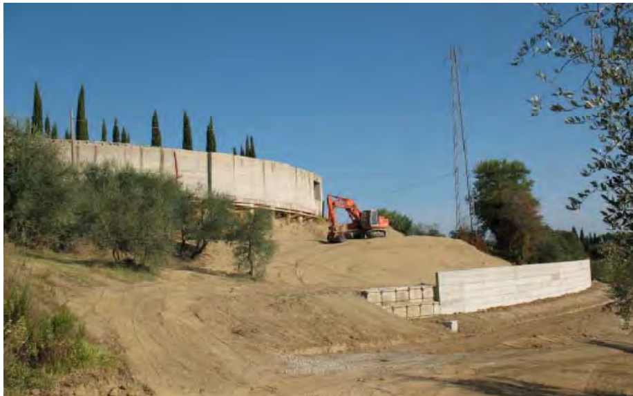
Foto 4 – Lavori di stabilizzazione e ricostruzione del versante (Luglio-Agosto 2011)
