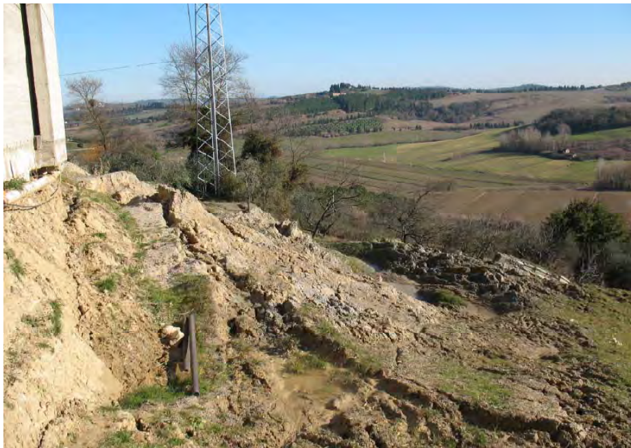
Foto 2 – Corpo della frana in corrispondenza del lato Est del Cimitero (Marzo 2011)
