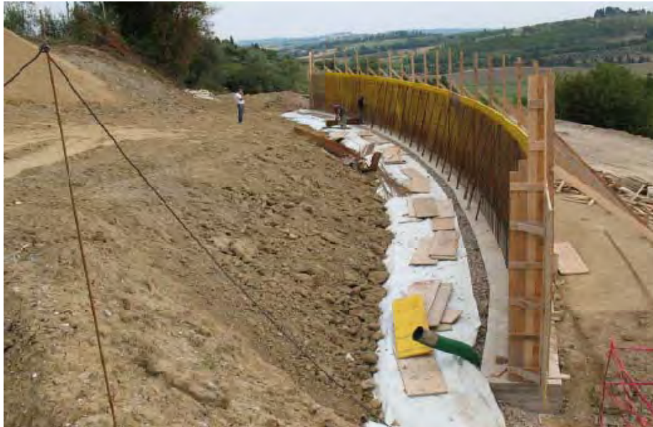
Foto 3 – Lavori di stabilizzazione e ricostruzione del versante (Luglio-Agosto 2011)
