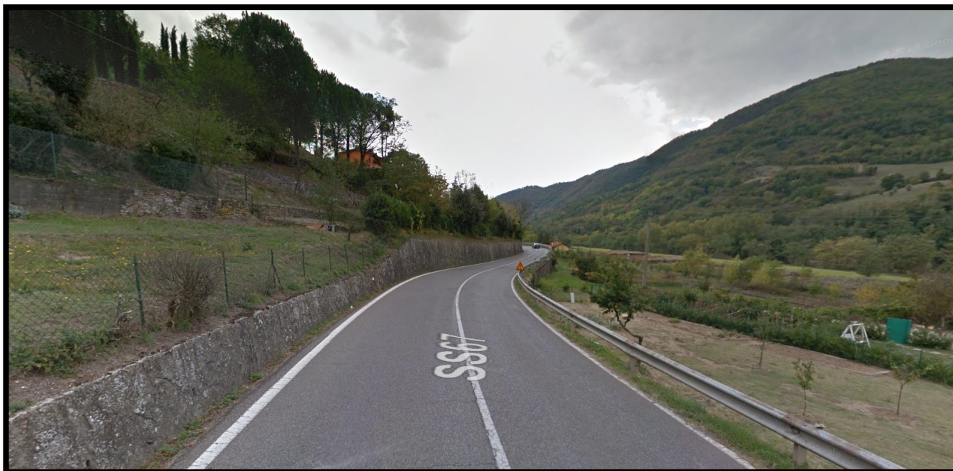
Figura 7: Strada S.S. 67 chilometrica 115-IX direzione Sud (fra Piandrats e Contea) – Assenza di marciapiede e banchina stretta
