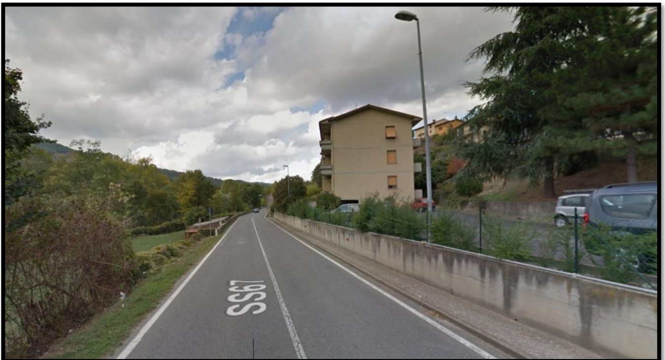
Figura 3: Strada S.S. 67 chilometrica 116-II direzione Nord (Zona abitato Piandratsi) – Presenza di Marciapiede sulla destra
