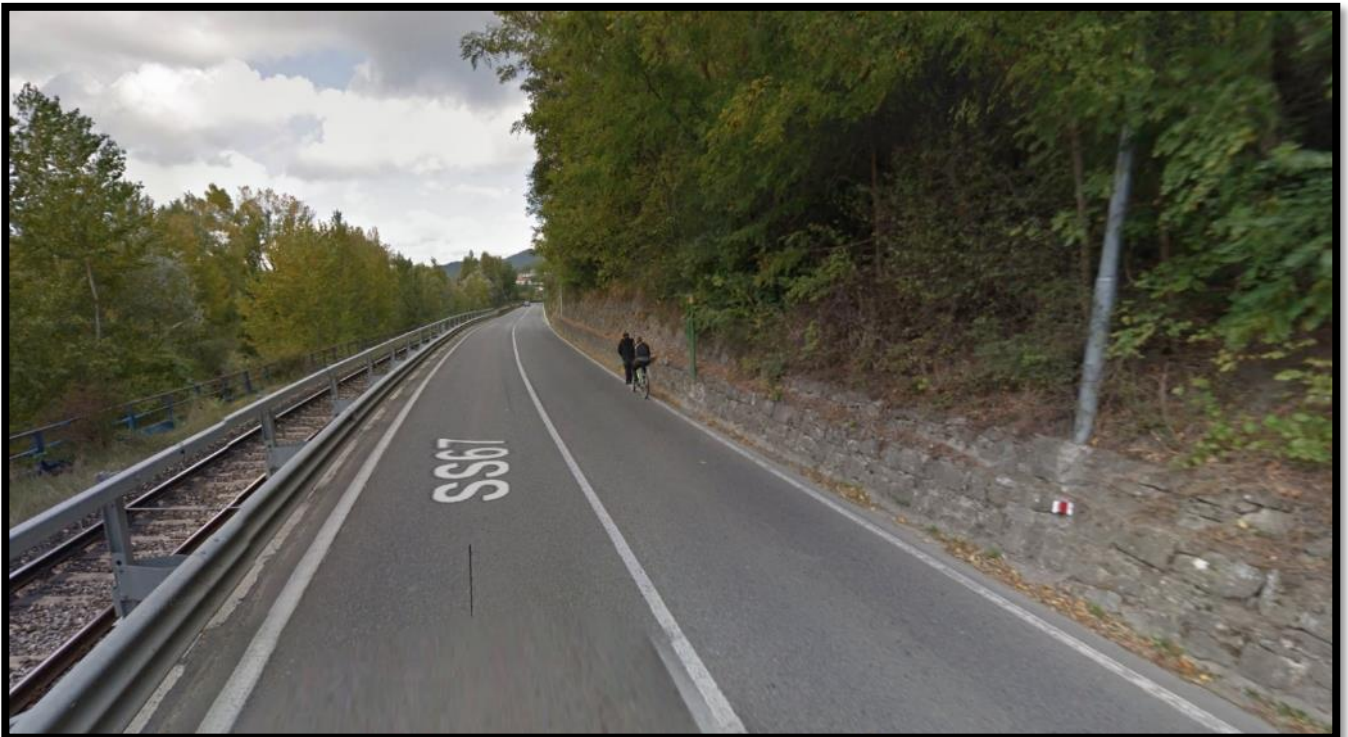
Figura 5: Strada S.S. 67 chilometrica 116-IV direzione Nord (fra Piandratì e Dicomano) – Assenza di marciapiede e banchina stretta
