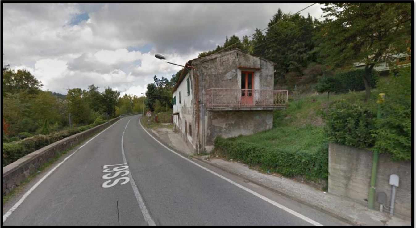
Figura 4: Strada S.S. 67 chilometrica 116-III direzione Nord (Zona abitato Piandratì) – Fine del tratto con Marciapiede sulla destra
