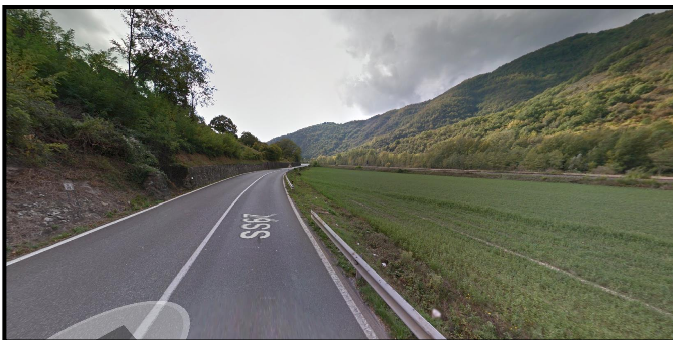
Figura 8: Strada S.S. 67 chilometrica 115-II direzione Sud (fra Piandrats e Contea) – Assenza di marciapiede e banchina stretta
