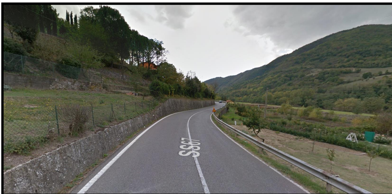
Figura 6: Strada S.S. 67 chilometrica 115-IX direzione Sud (fra Piandrats e Contea) – Assenza di marciapiede e banchina stretta
