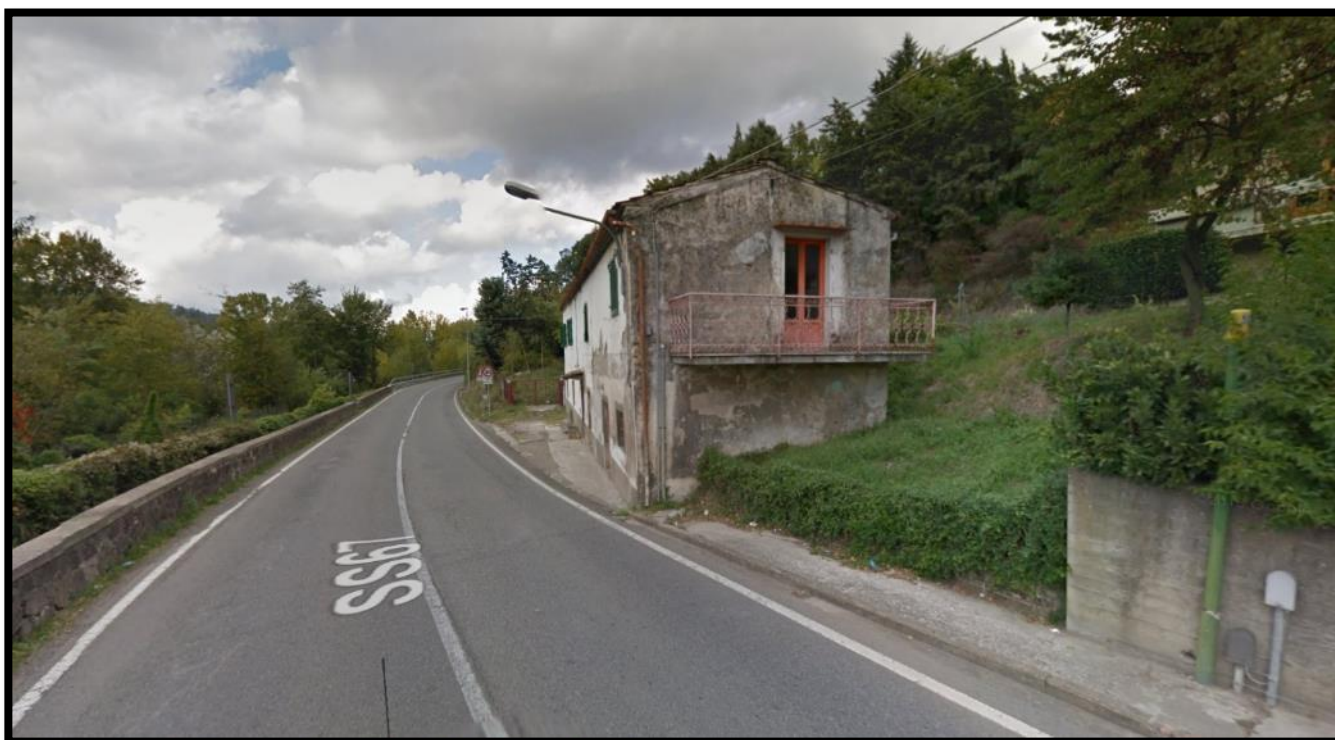
Figura 3: Strada S.S. 67 chilometrica 116-III direzione Nord (Zona abitato Piandratì) – Fine del tratto con Marciapiede sulla destra
