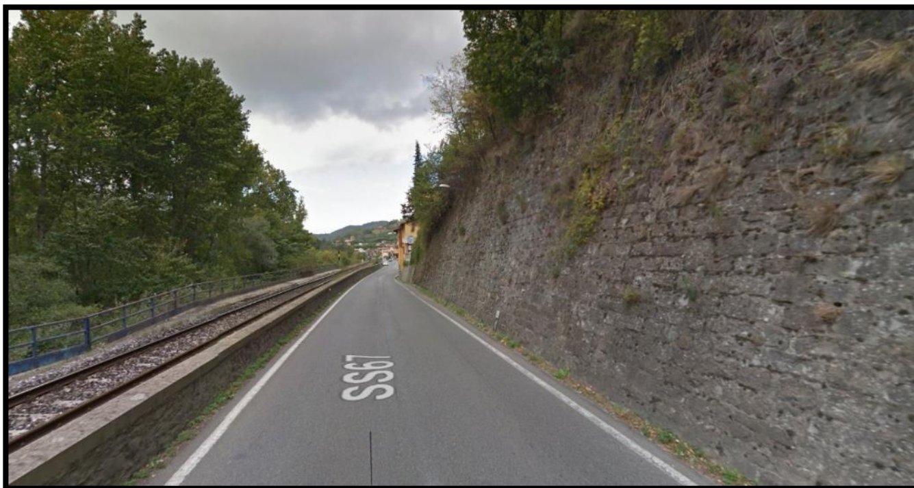
Figura 5: Strada S.S. 67 chilometrica 116-VI direzione Nord (fra Piandrats e Dicomano) – Assenza di marciapiede e banchina stretta
