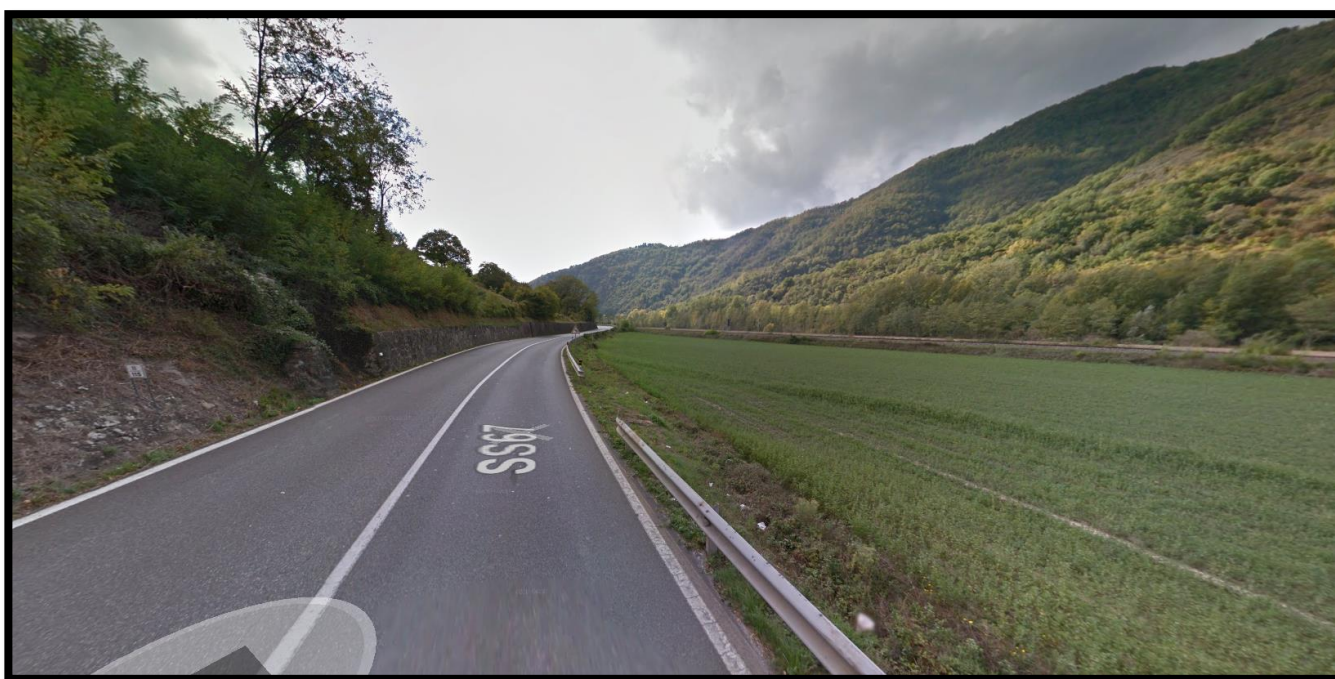
Figura 7: Strada S.S. 67 chilometrica 115-II direzione Sud (fra Piandrats e Contea) – Assenza di marciapiede e banchina stretta
