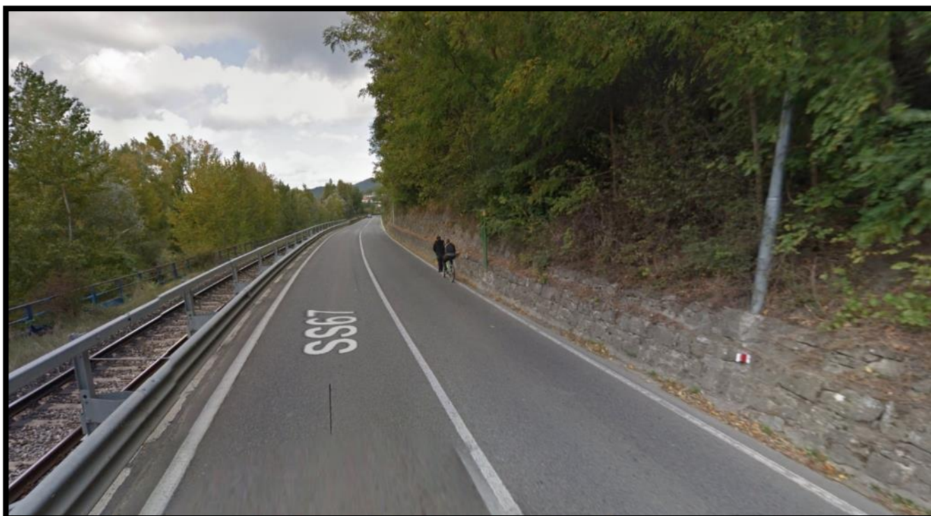
Figura 4: Strada S.S. 67 chilometrica 116-IV direzione Nord (fra Piandratì e Dicomano) – Assenza di marciapiede e banchina stretta
