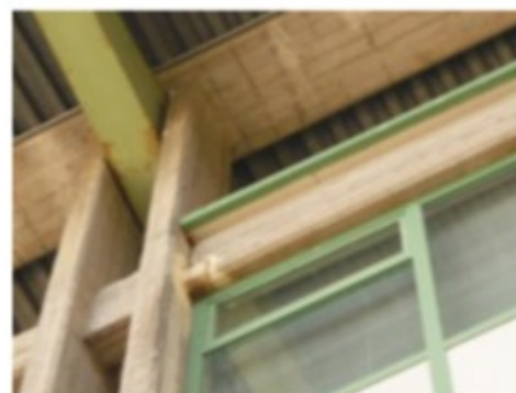
FOTO 9: Collegamento tirante in c.a.-trave metallica
