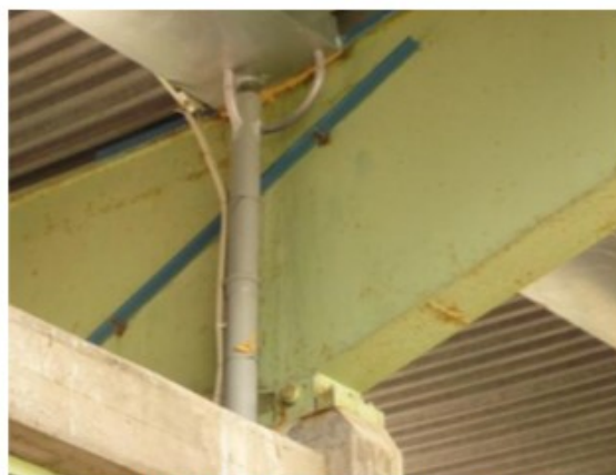
FOTO 6: Cerniera d'appoggio copertura
