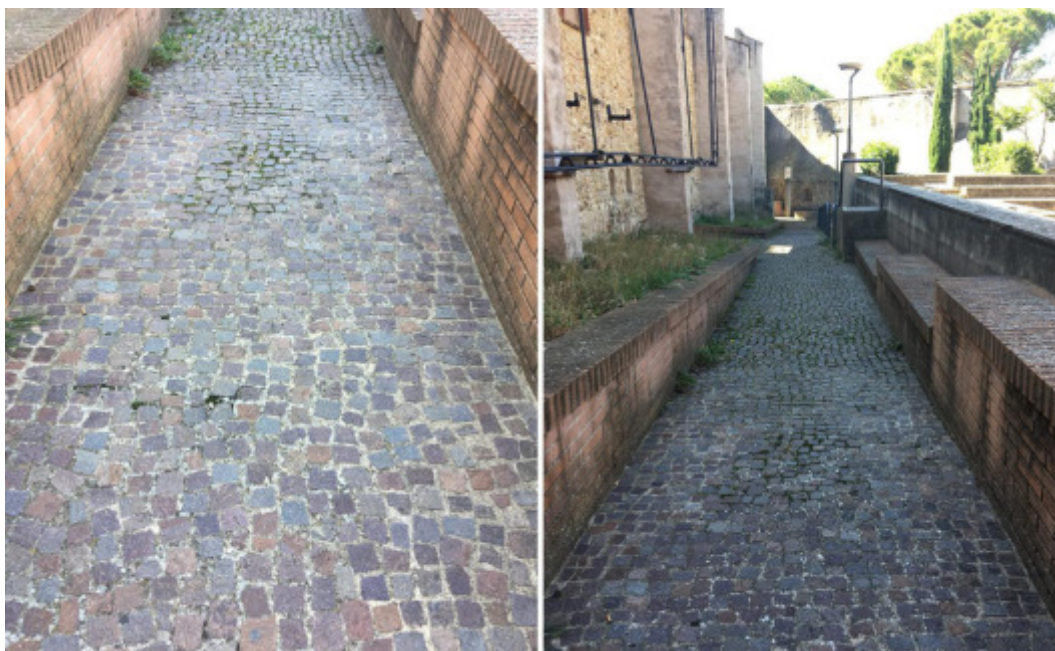
Fig. B-10) Accesso da via Lucardesi, rampe di accesso a bassa pendenza e pavimentate con cubetti di porfido posati con malta.
