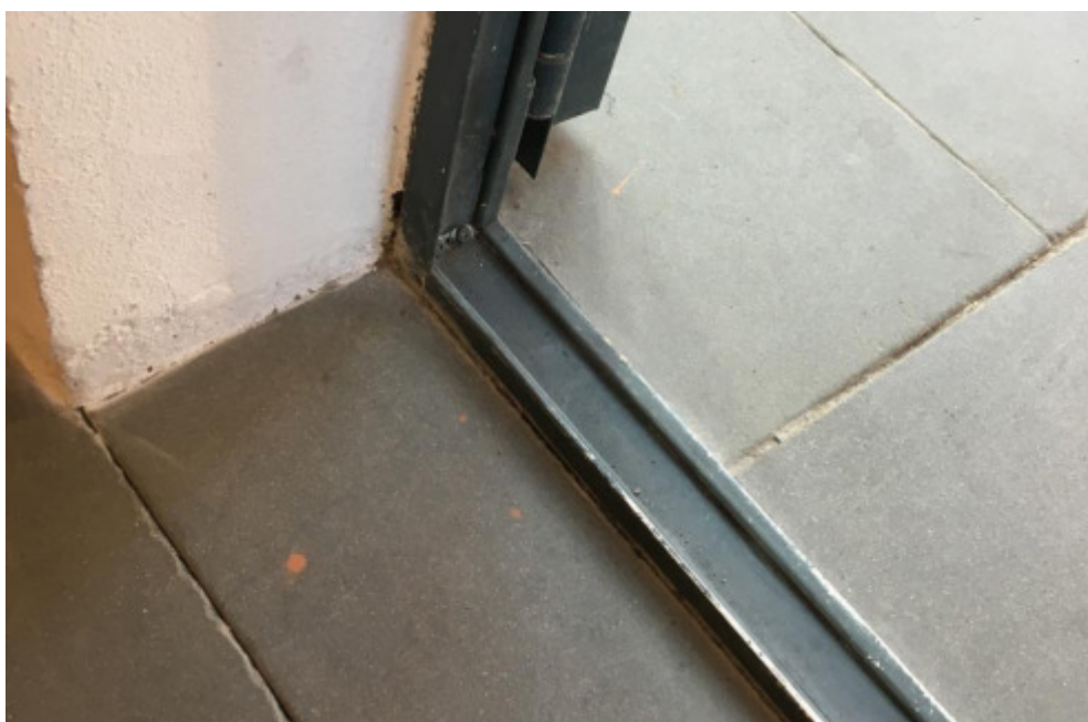
Fig. C-3) Si raccomanda di evitare, quando possibile, la presenza di traverse a pavimento in corrispondenza delle porte. Quando inevitabile queste dovrebbero avere altezza inferiore ai 2,5 cm (consigliabile 1,5-2 cm) ed essere raccordate al piano del pavimento tramite smusso (vedi fig. C-2)
