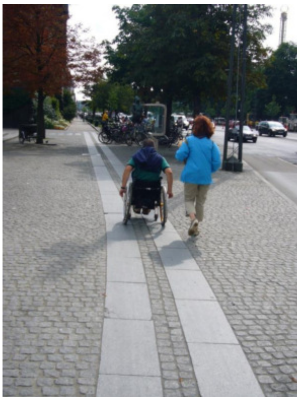
Fig. B-11) Esempio di pavimentazione in cubetti di porfido con inserite delle fasce a ruvidezza attenuata (elementi in pietra lastriformi) che favoriscono il transito di persone con sedia a ruote. La differenza di ruvidezza tra superfici adiacenti crea anche un riferimento -linea guida naturale- utile a persone cieche che si muovono utilizzando il bastone bianco.
