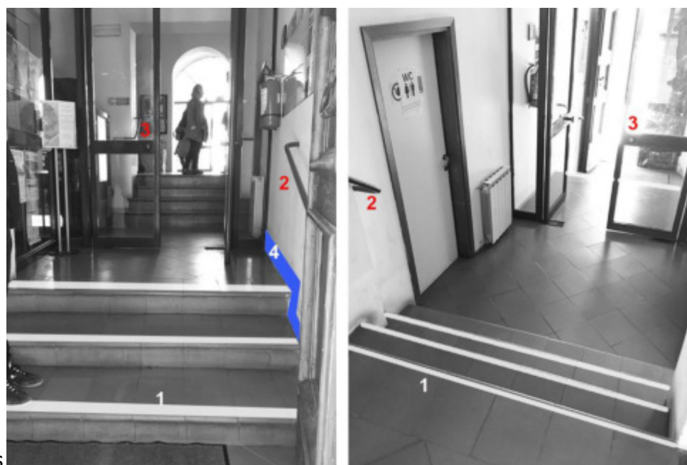
Fig. B-4) Suggestioni per migliorare l'accessibilità e la sicurezza d'uso nella parte interna dell'ingresso su via Roma. 1) inserimento di marcagradino per evidenziare i passaggi di livello. 2) Predisporre un corrimano continuo, preferibilmente doppio (altezza primo corrimano 100 cm, secondo altezza 75 cm). 3) Sostituzione porta a vetro ad anta con porta vetro scorrevole ad apertura automatica. 4) Zoccolino battiscopa con funzione di segnare, a parete, l'andamento della rampa e del percorso. Migliorare l'illuminazione generale dell'ingresso, anche tramite inserimento di luci segnapasso.
