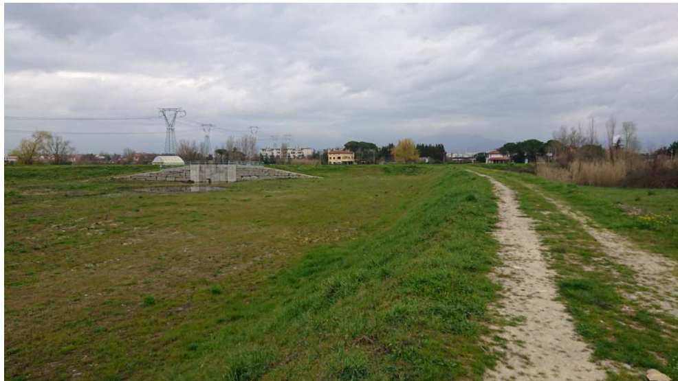
Figura 11 Stato attuale argine cassa di espansione
