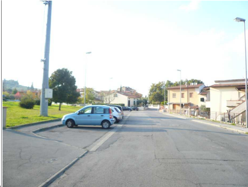
Figura 7 Stato attuale Via Cegoli
