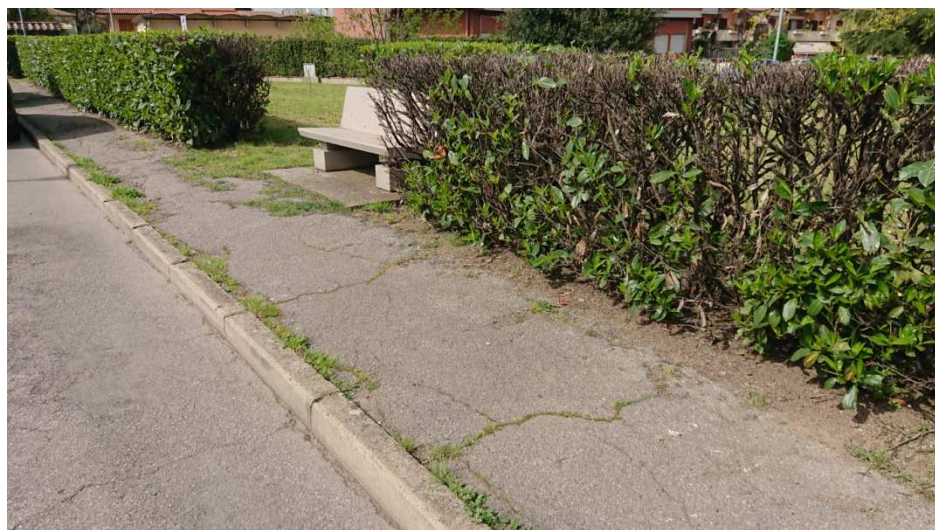
Figura 6 Stato attuale Via Cegoli
