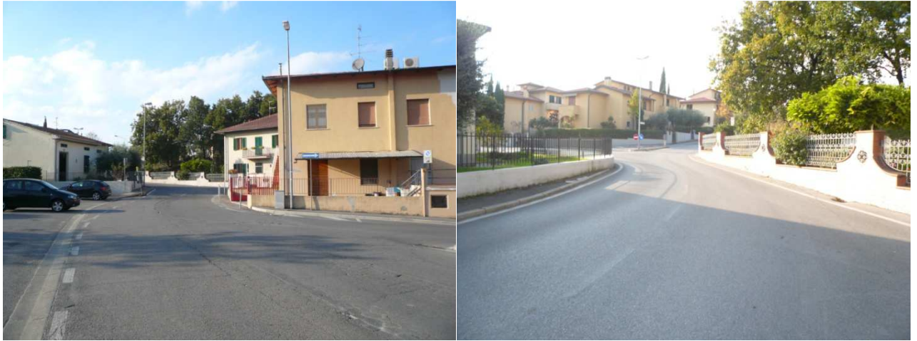
Figura 8 Stato attuale Via Aiaccia
