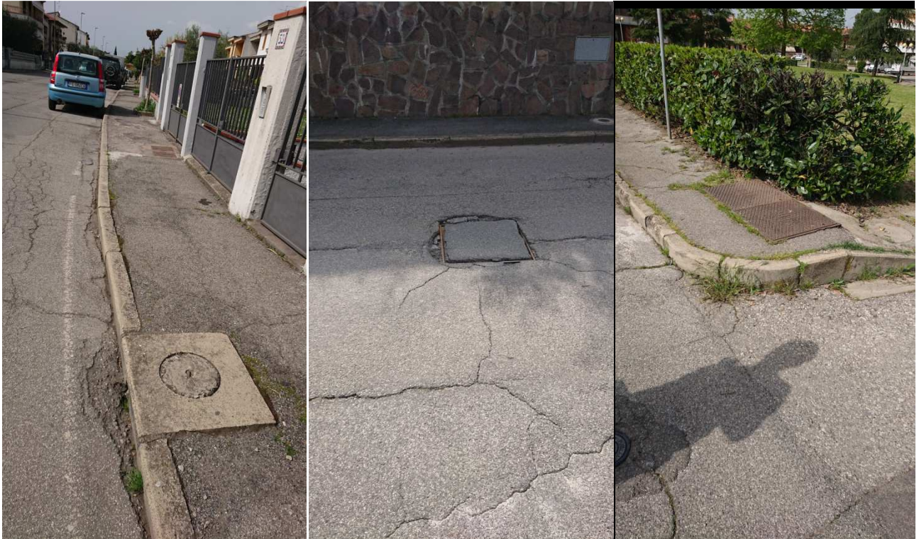
Figura 5 Stato attuale Via Cegoli
