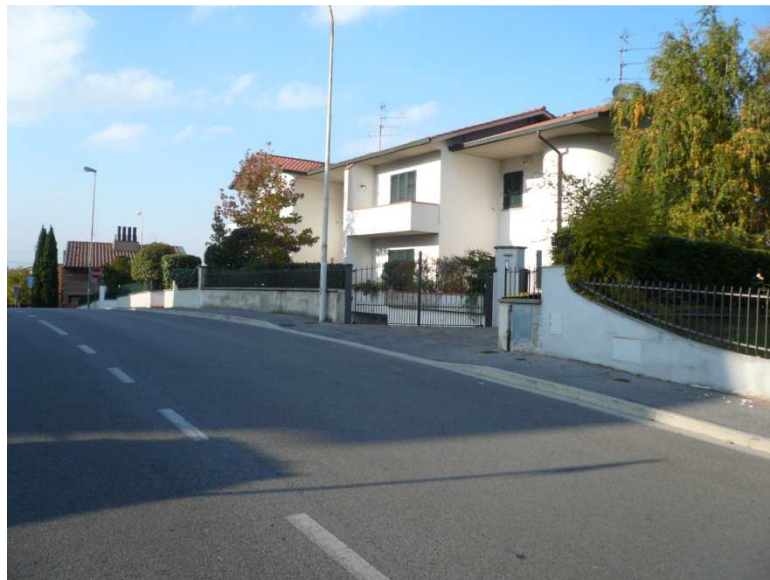
Figura 9 Stato attuale Via Cegoli
