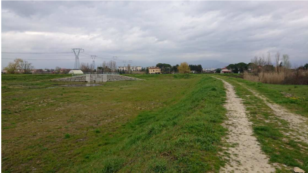
Figura 10 Stato attuale argine cassa di espansione
