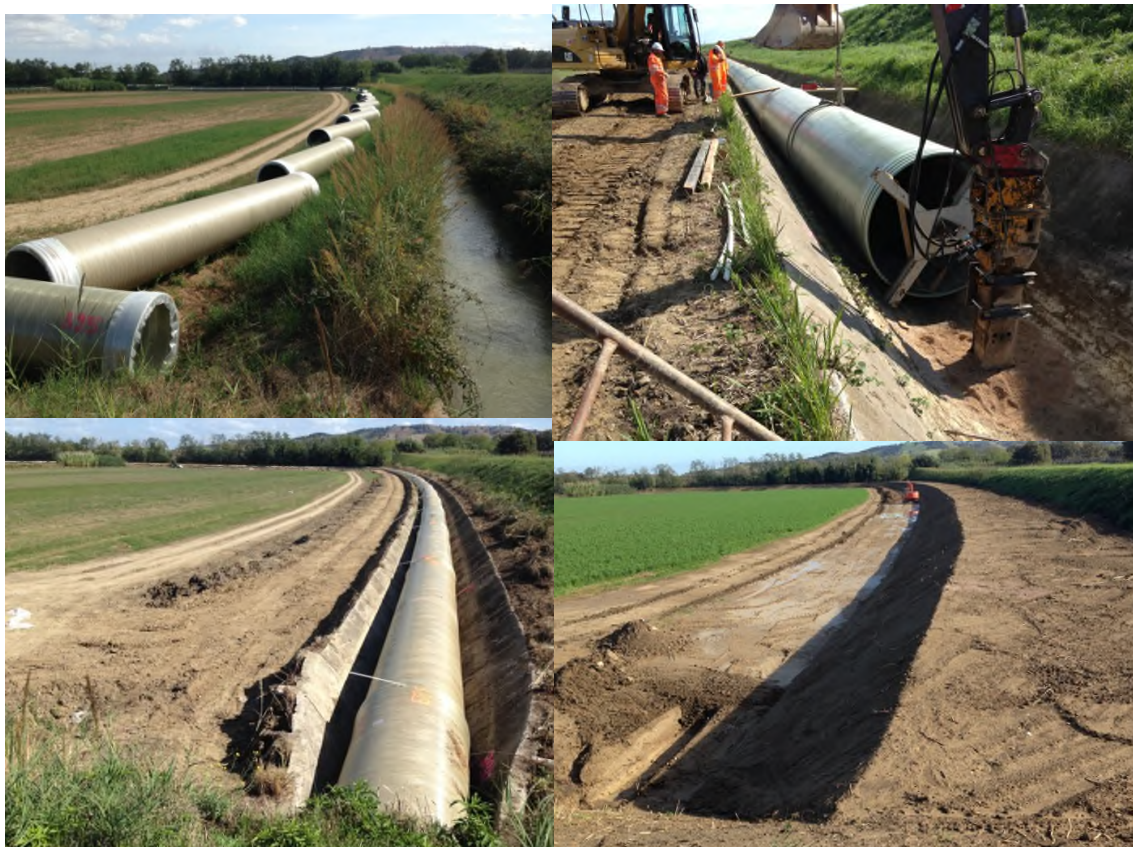
Lavori simili eseguiti dal consorzio bonifica nel Lotto 226/2° str
