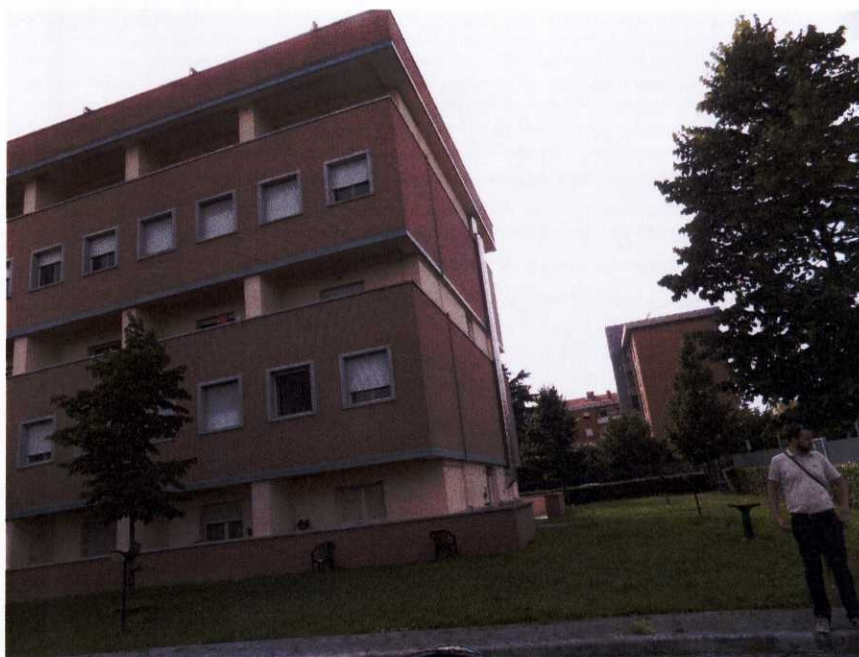
Vista esterna laterale
