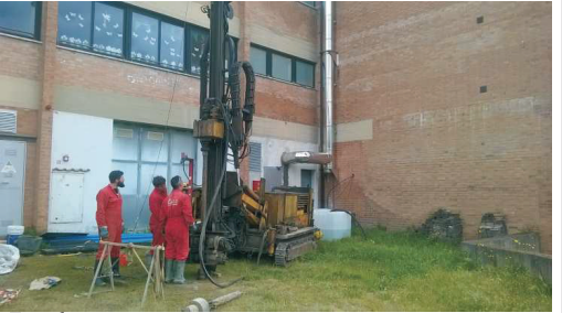
Fase di cantiere
