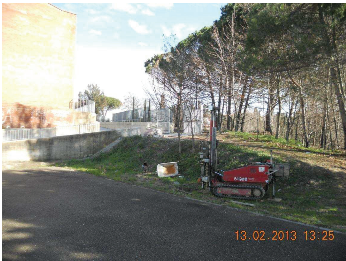
Figura 1: Prova penetrometrica DSH1
