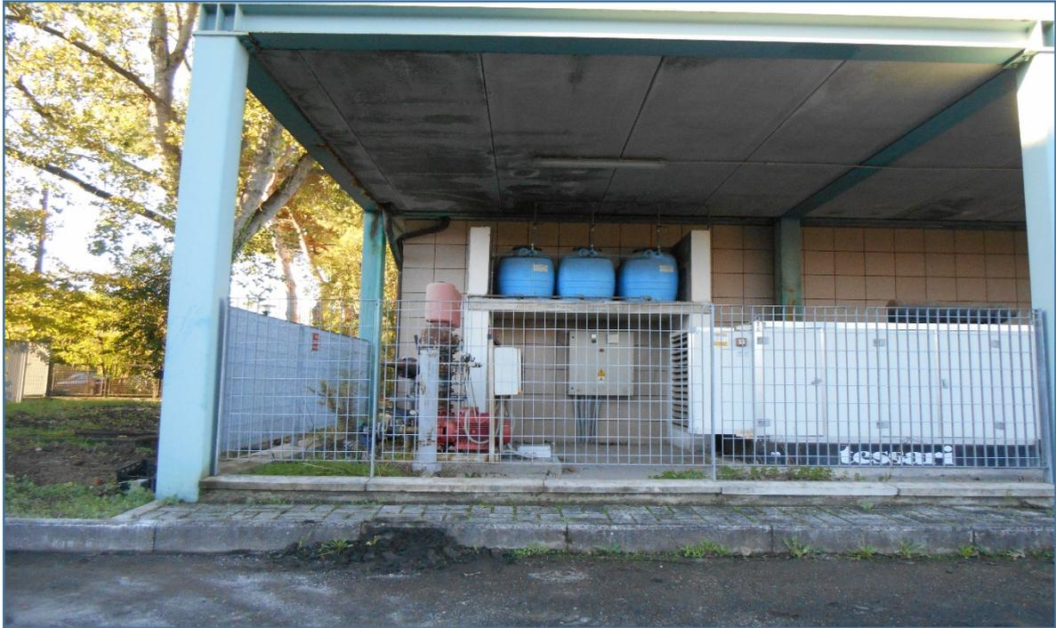
VISTA COMPLESSIVA SISTEMA POMPAGGIO IMPIANTO IDRICO ANTINCENDIO
