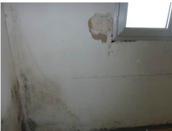
Muffe sulla parete esterna
