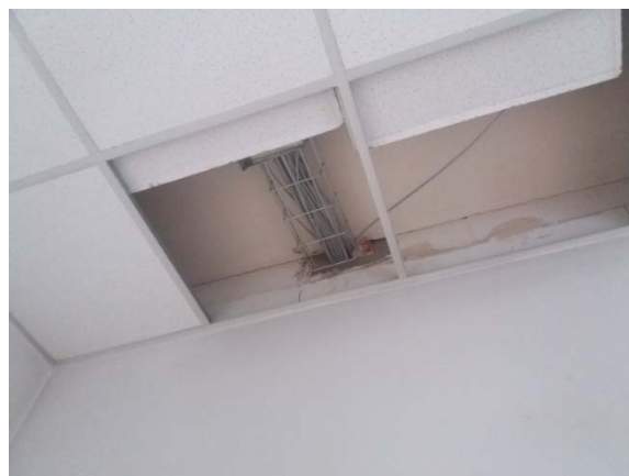
Controsoffitto utilizzato per passaggio impianti
