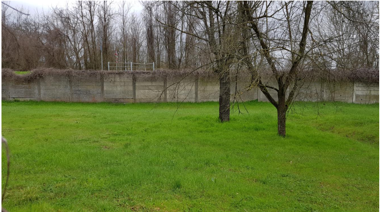
Figura 2-3 Recinzione esistente, costituita da pannelli prefabbricati in c.a.v. di altezza 2.00 m, posta al di confine della proprietà Enel.
