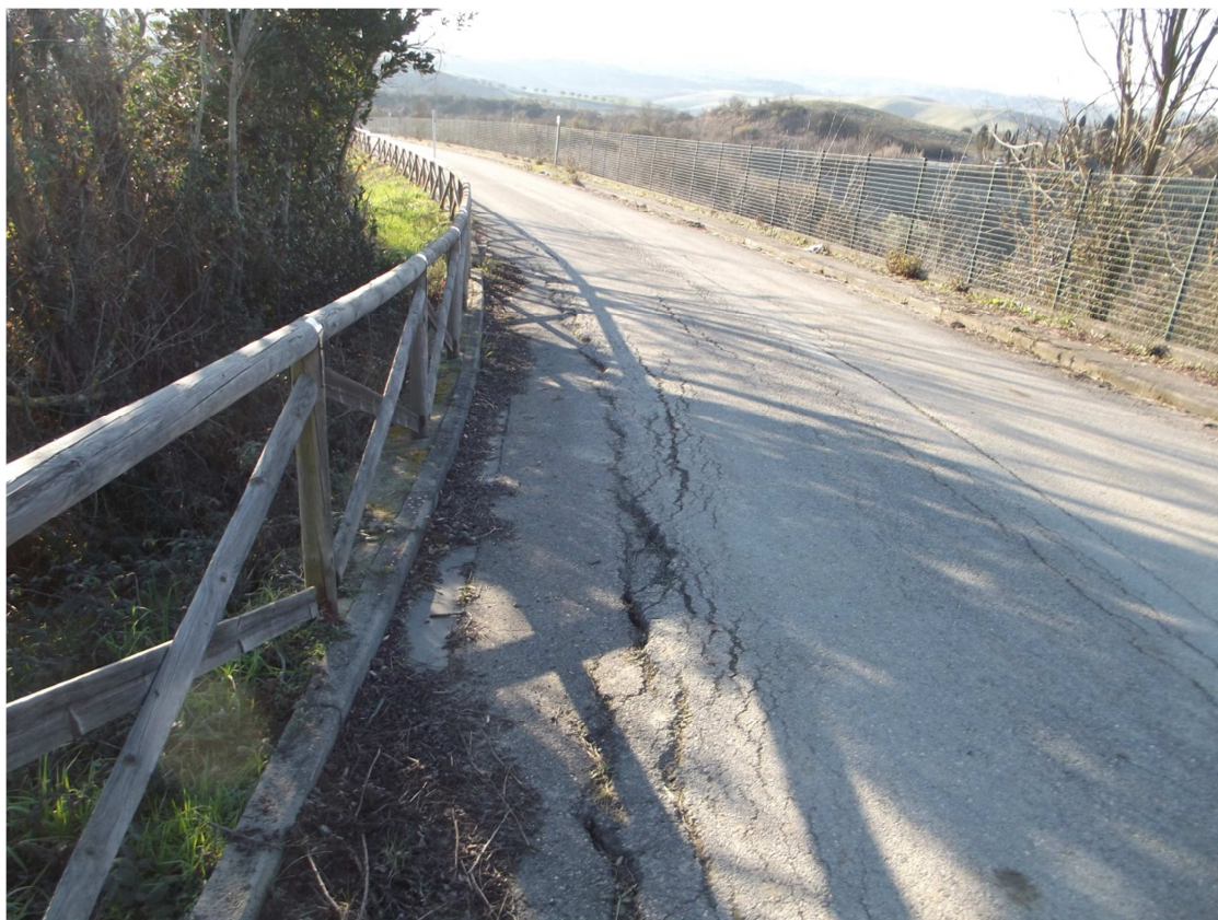
Figura 5 - altra localizzazione di fessurazioni longitudinali
