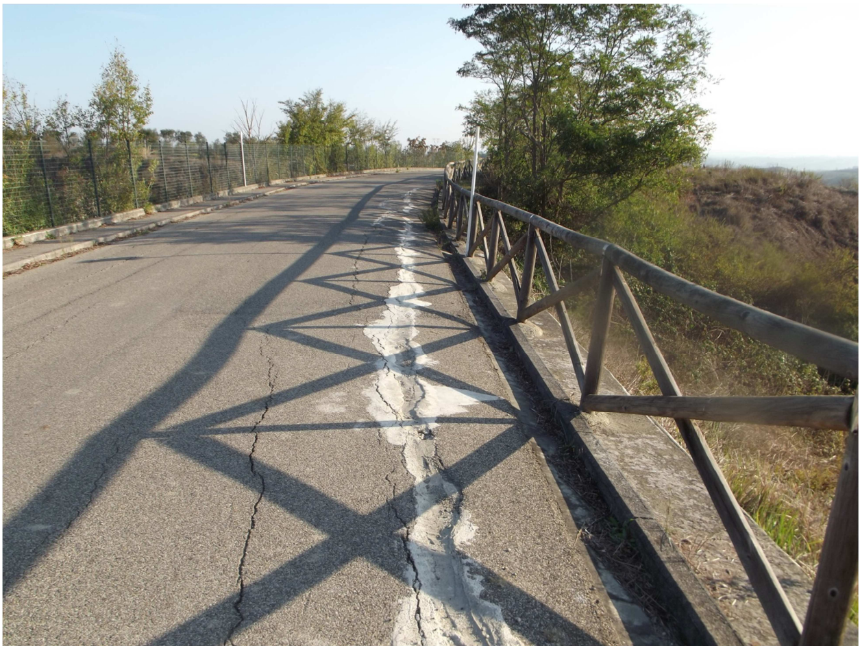
Figura 4 - Fessurazioni longitudinali localizzate
