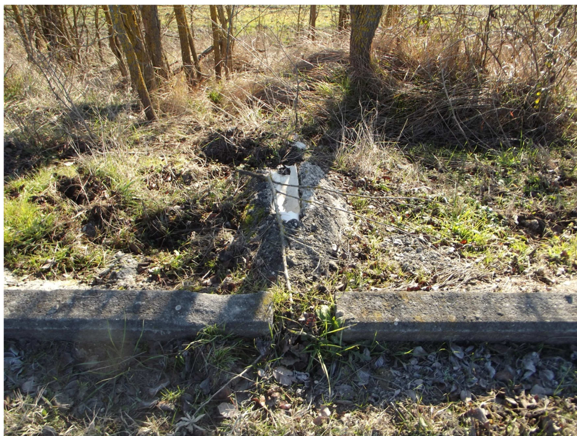
Figura 6 - Scoli laterali completamente inefficienti da sostituire
