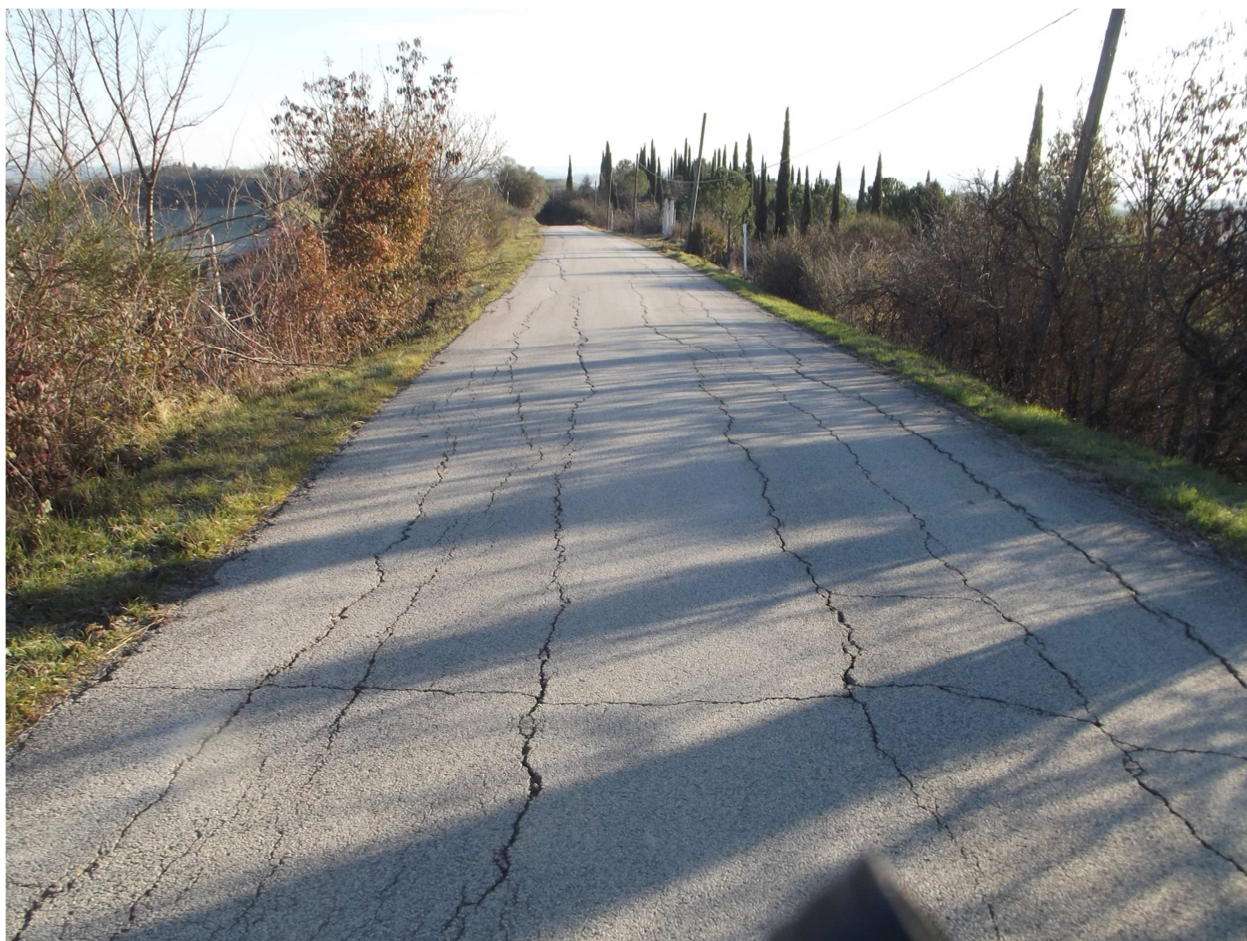
Figura 9 - Fessure nella pavimentazione lungo tutto il tratto
