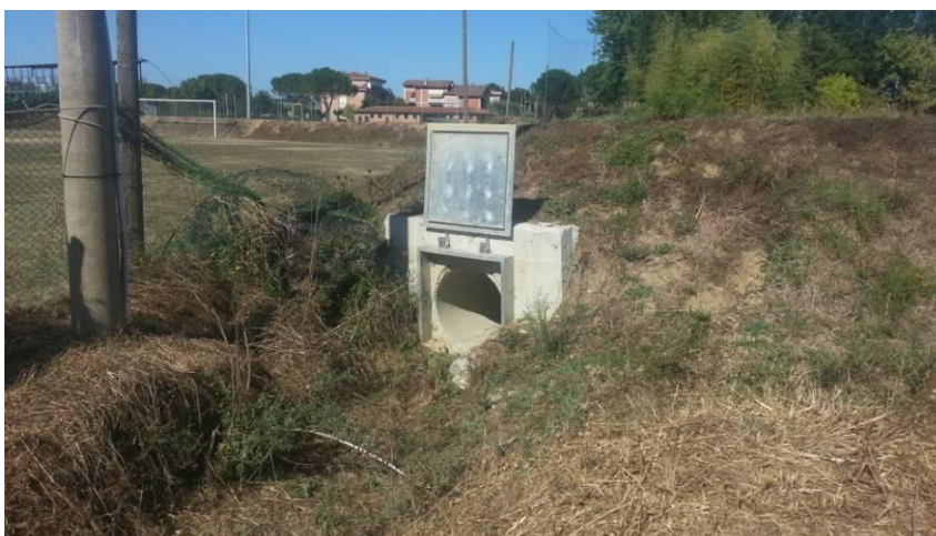
Foto 10 - vista dello sbocco del tombino n.2 DN800
