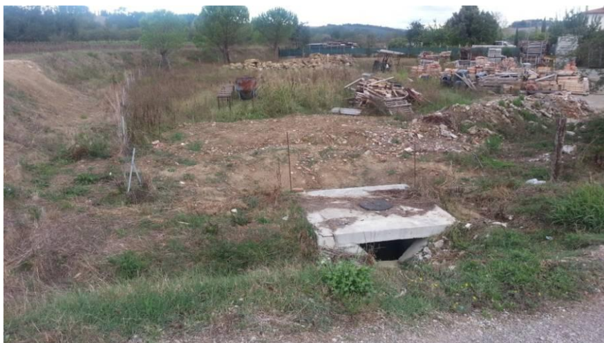
Foto 14 - vista della zona del pozzetto di imbocco del tombino 3 DN1500 dove è prevista la realizzazione della vasca di carico dell'impianto idrovoro
