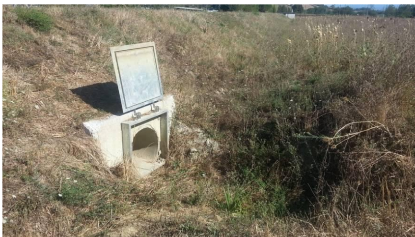
Foto 11 - vista dello sbocco del tombino n.4 DN800
