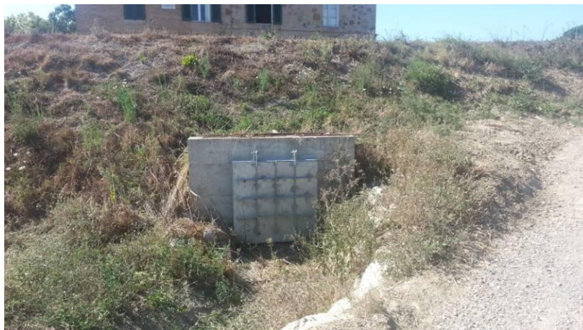
Foto 9 - vista dello sbocco del tombino n.1 DN800
