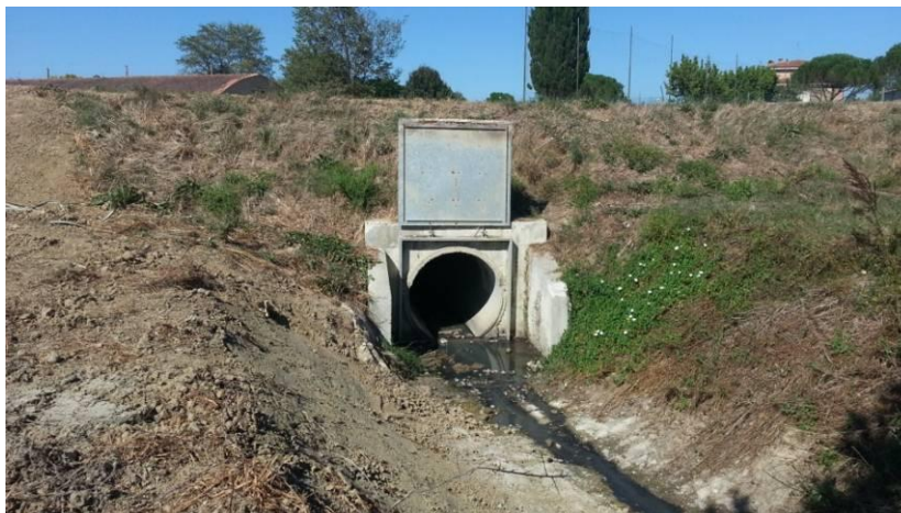
Foto 12 - vista dello sbocco del tombino n. 3 DN1500
