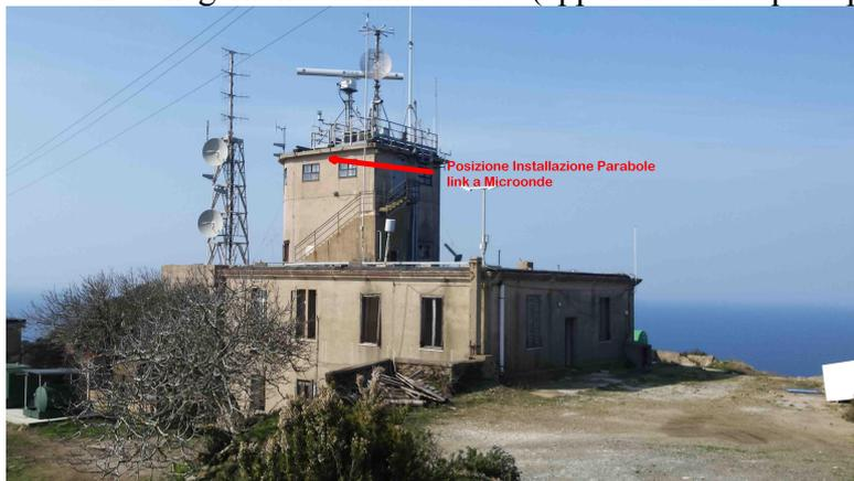
Dal punto di posizionamento delle parabole, per tramite di condotta formata da tubazione plastica rigida di tipo elettrico con grado di protezione IP 55 si dovrà, attraverso apposito foro da realizzare nel muro esistente, di dovrà raggiungere l'armadio rack della postazione
