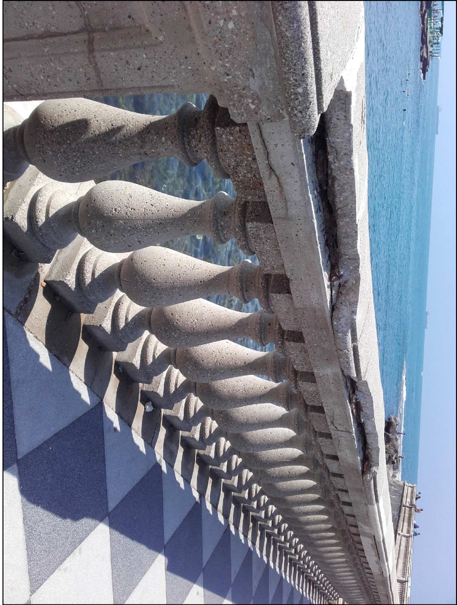
D, C - particolare tappi pilastri e cimase danneggiate
