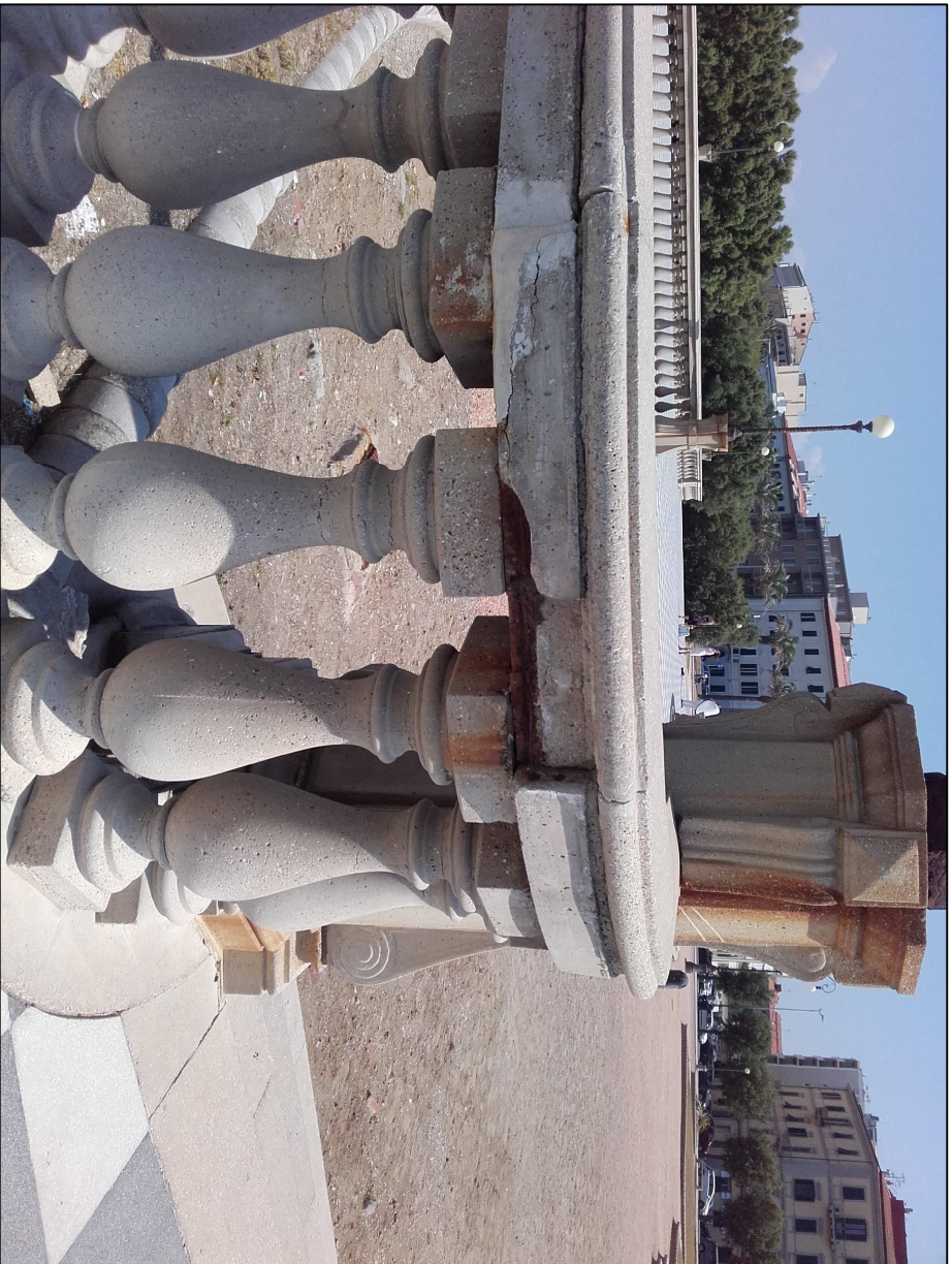
C - particolare cimase danneggiate
