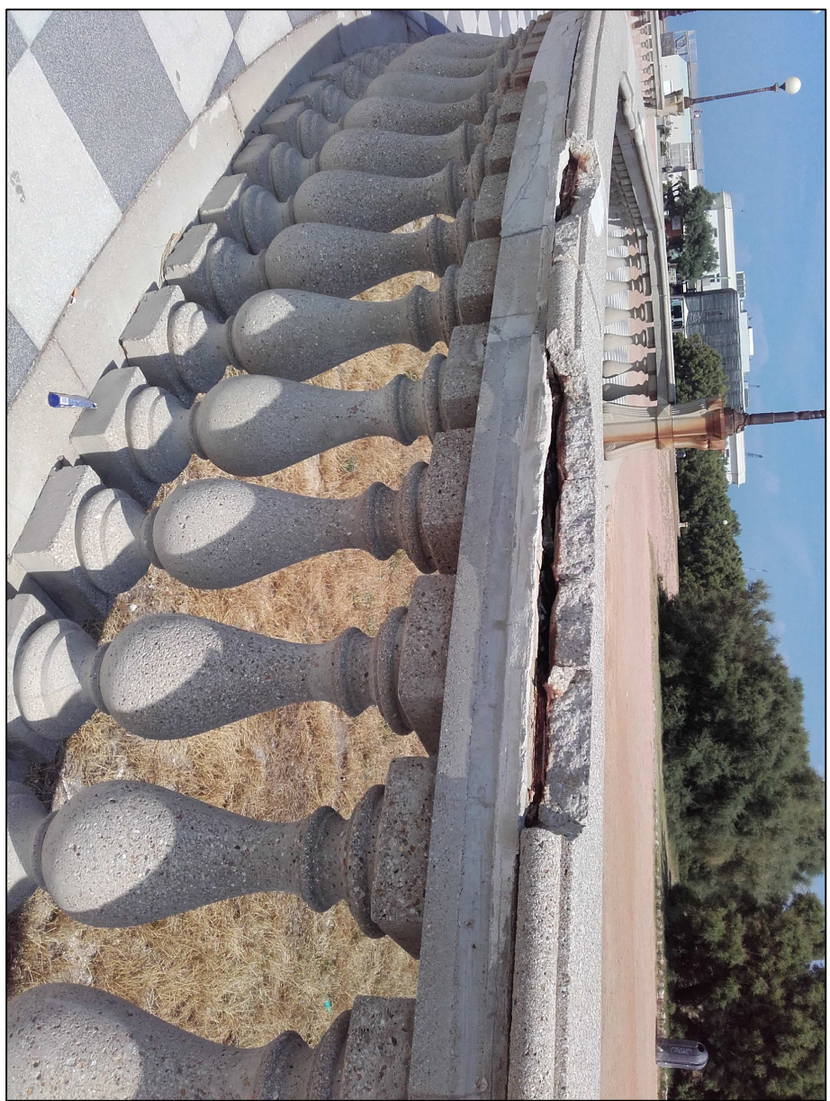
C - particolare cimase danneggiate
